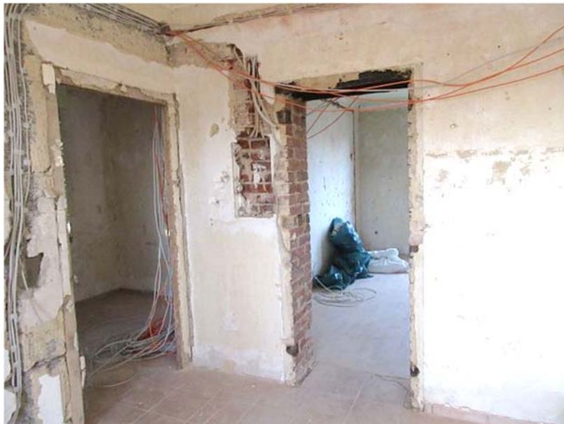
Umbaumaßnahme u.a. Elektroanlage
