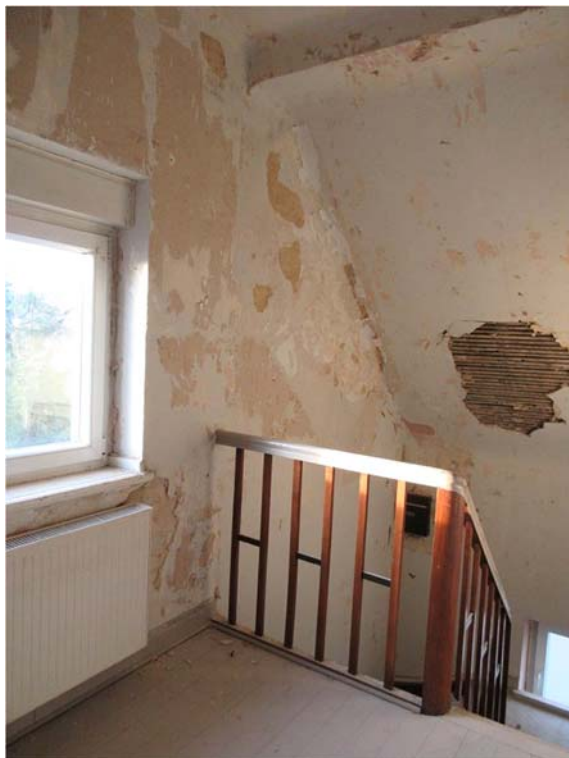
Putzabplatzung / Dachschräge
