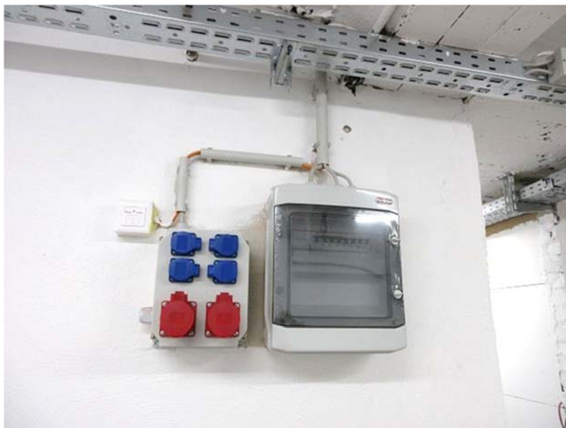
Sicherungskasten / Baustromverteiler
