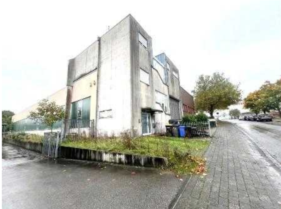
Straßenansicht der Gebäude B1, B2 und B3 und C aus Nordwesten
