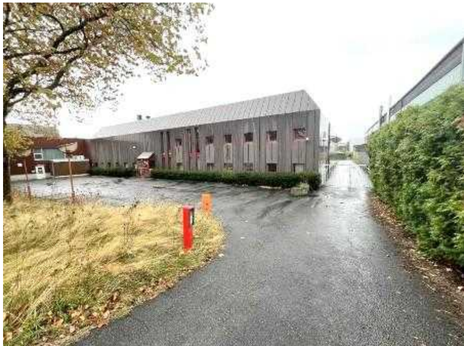
Straßenansicht der Halle A1
