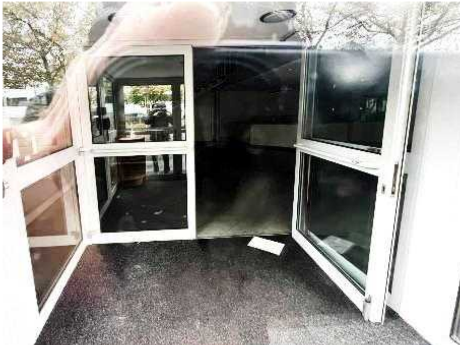
Eingangssituation Halle A1
