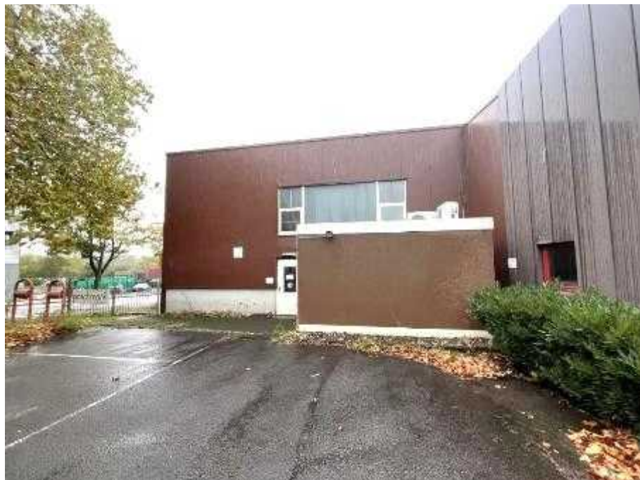
Teilansicht Halle C mit vorgelagerter Transformatorstation
