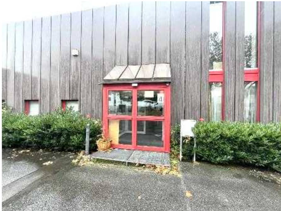
Vorderer Zugang zu Halle A1
