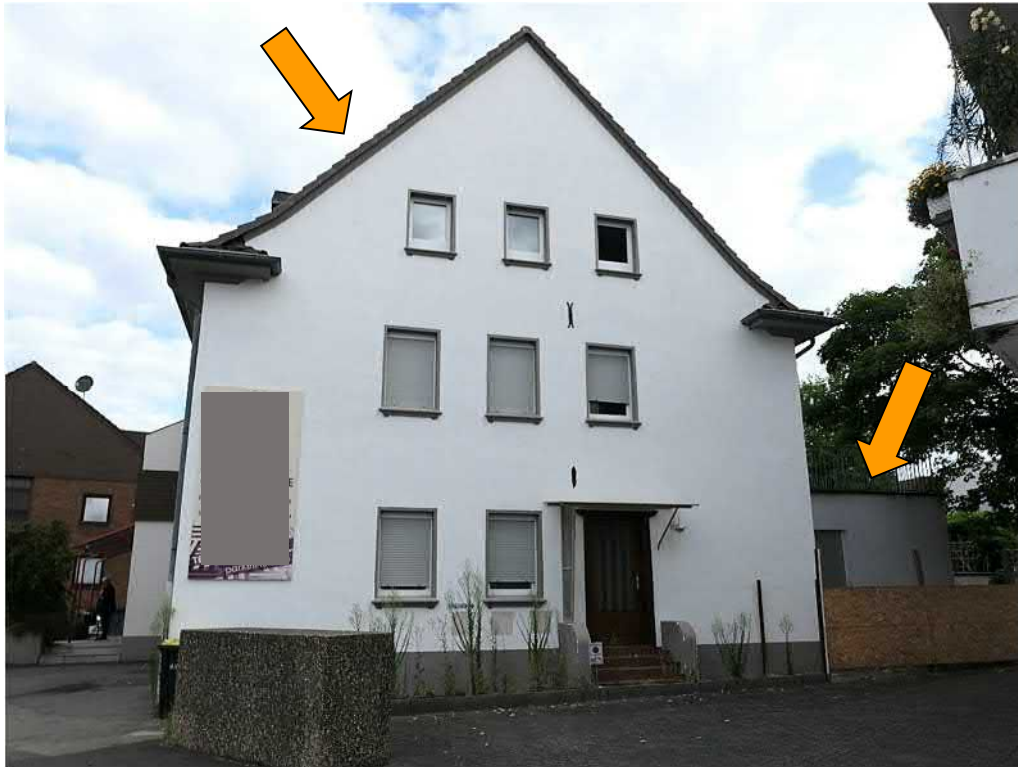
Straßenansicht Dreifamilienhaus mit Anbau von Süden
