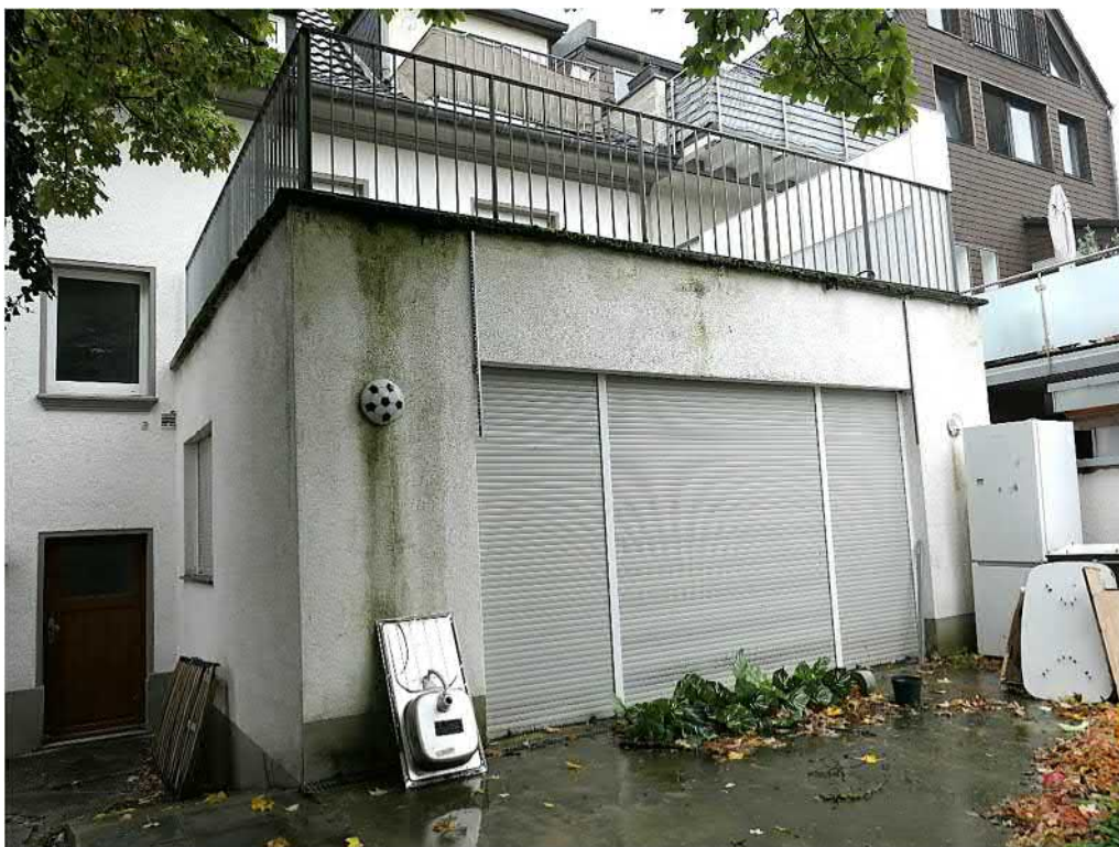
Rückseitige Ansicht Dreifamilienhaus mit Anbau
