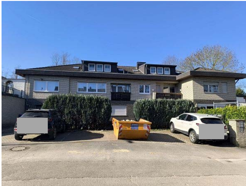
Straßenansicht Buschhausen 12 a mit vorgelagerten Stellplätzen
