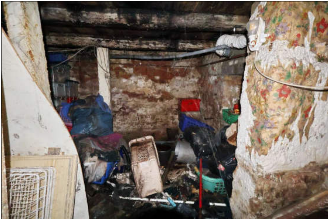
Abbildung 20 Kellergeschoss Foto Nr. 16, fotografiert am 19.03.2026
