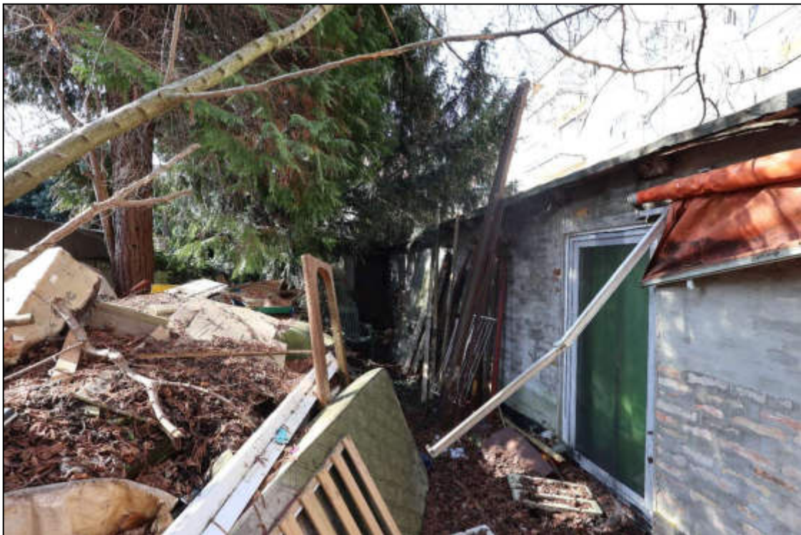
Abbildung 9 Seitenansicht des Werkstattanbaus Foto Nr. 5, fotografiert am 19.03.2026
