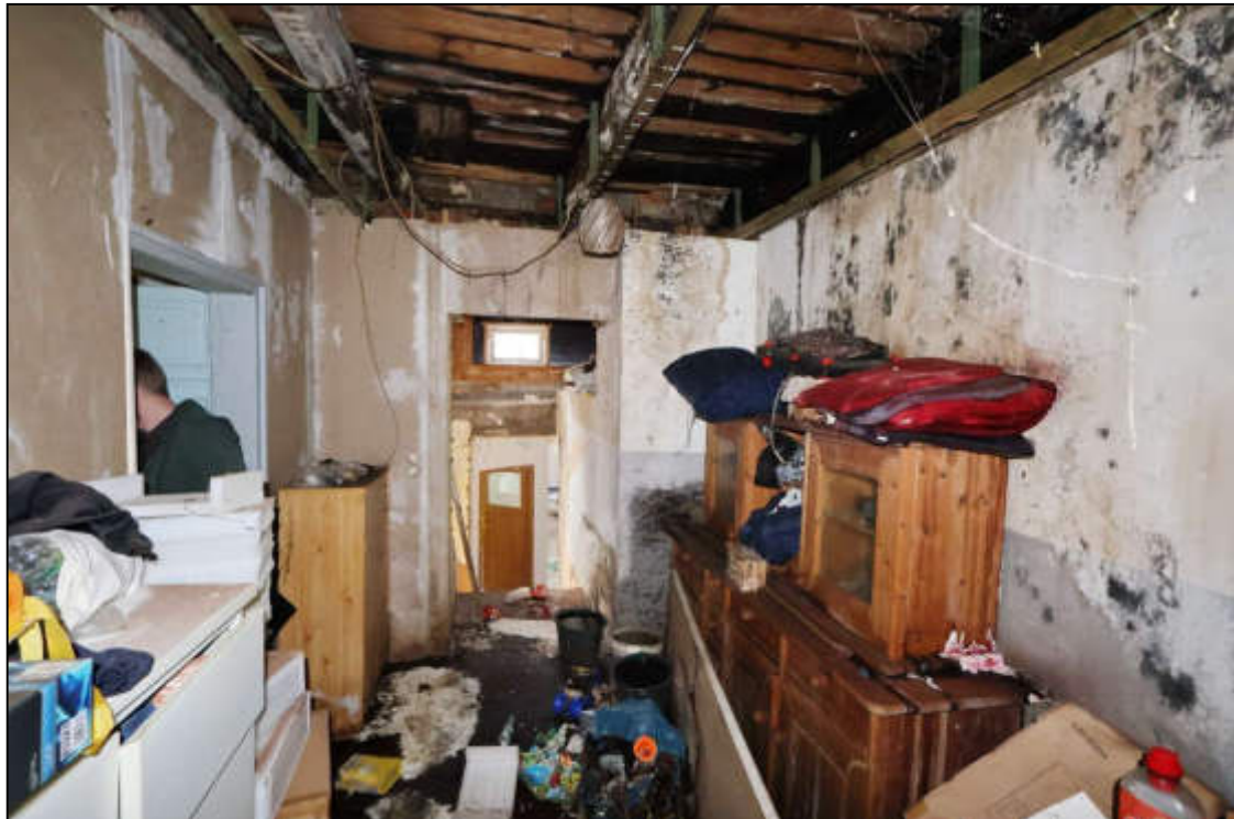
Abbildung 11 Flur im Erdgeschoss Foto Nr. 7, fotografiert am 19.03.2026
