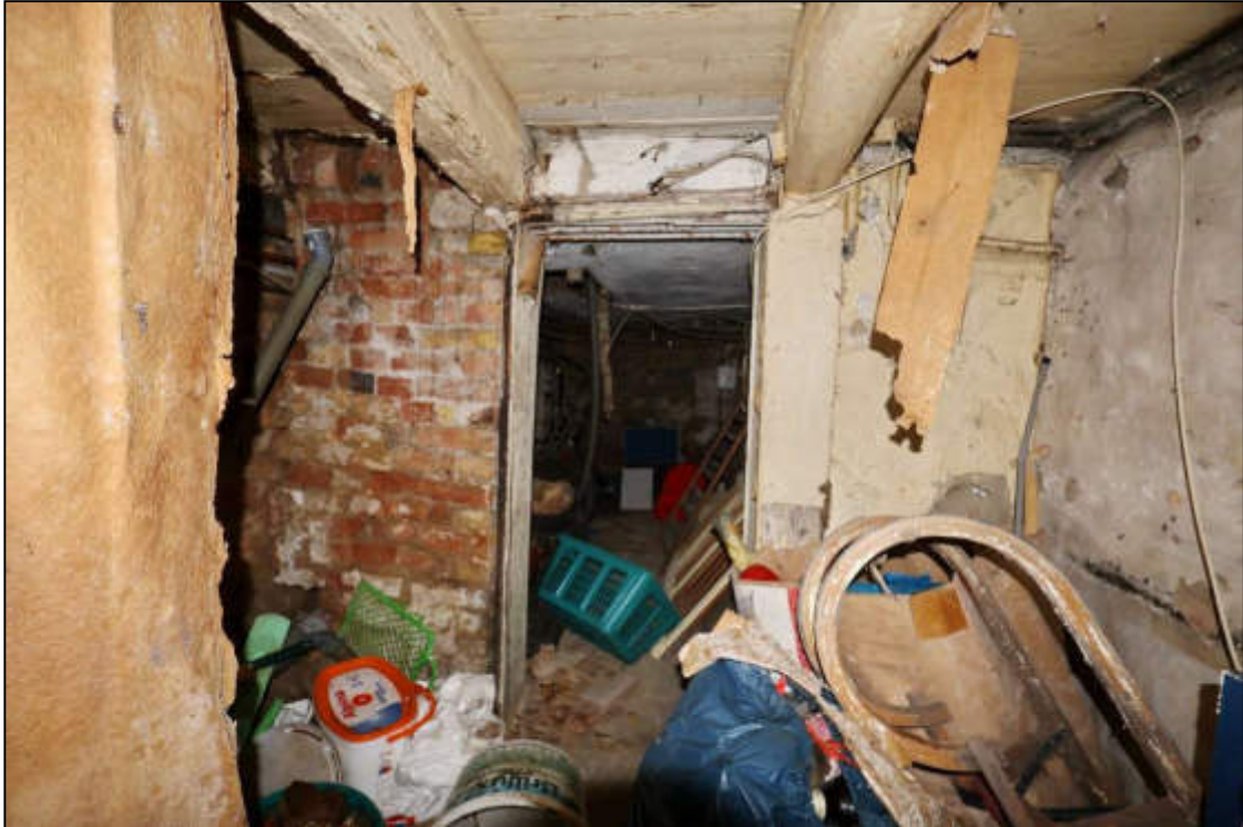
Abbildung 18 Kellergeschoss Foto Nr. 14, fotografiert am 19.03.2026
