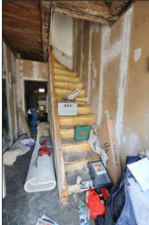
Abbildung 10 Flur und Eingangsbereich im Erdgeschoss Foto Nr. 6, fotografiert am 19.03.2026
