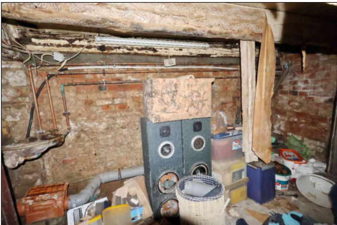
Abbildung 19 Kellergeschoss Foto Nr. 15, fotografiert am 19.03.2026
