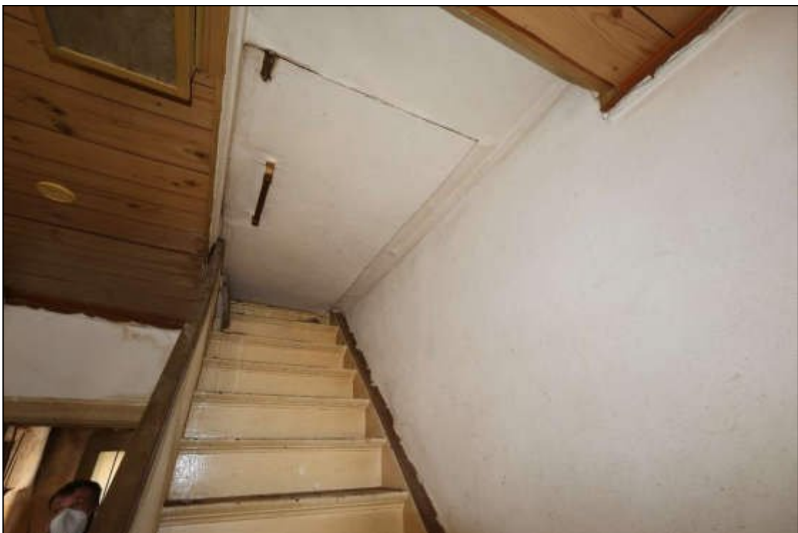
Abbildung 25 Treppenzugang zum Dachgeschoss Foto Nr. 21, fotografiert am 19.03.2026
