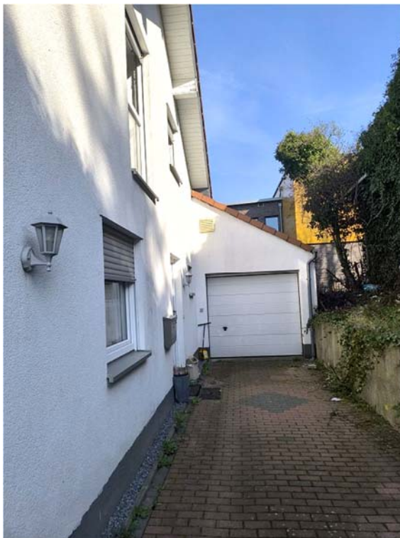
Hauseingang, Garagenzufahrt und seitliche Stützmauer zu Schulgelände
