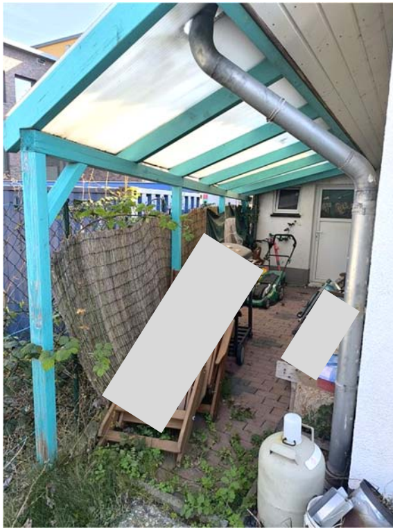
Überdachung in Holzkonstruktion, hintere Grundstücksgrenze
