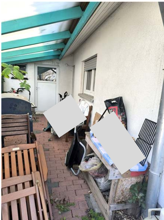
hintere Fassade und Zugang Garage
