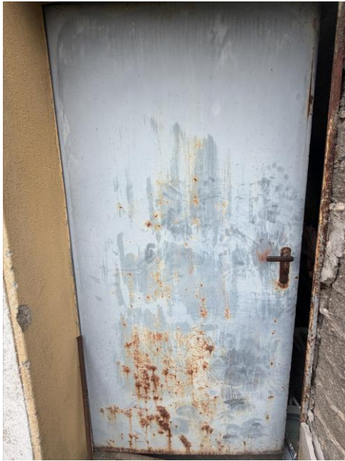
Rückwärtiger Zugang zum Raum unterhalb des Balkons
