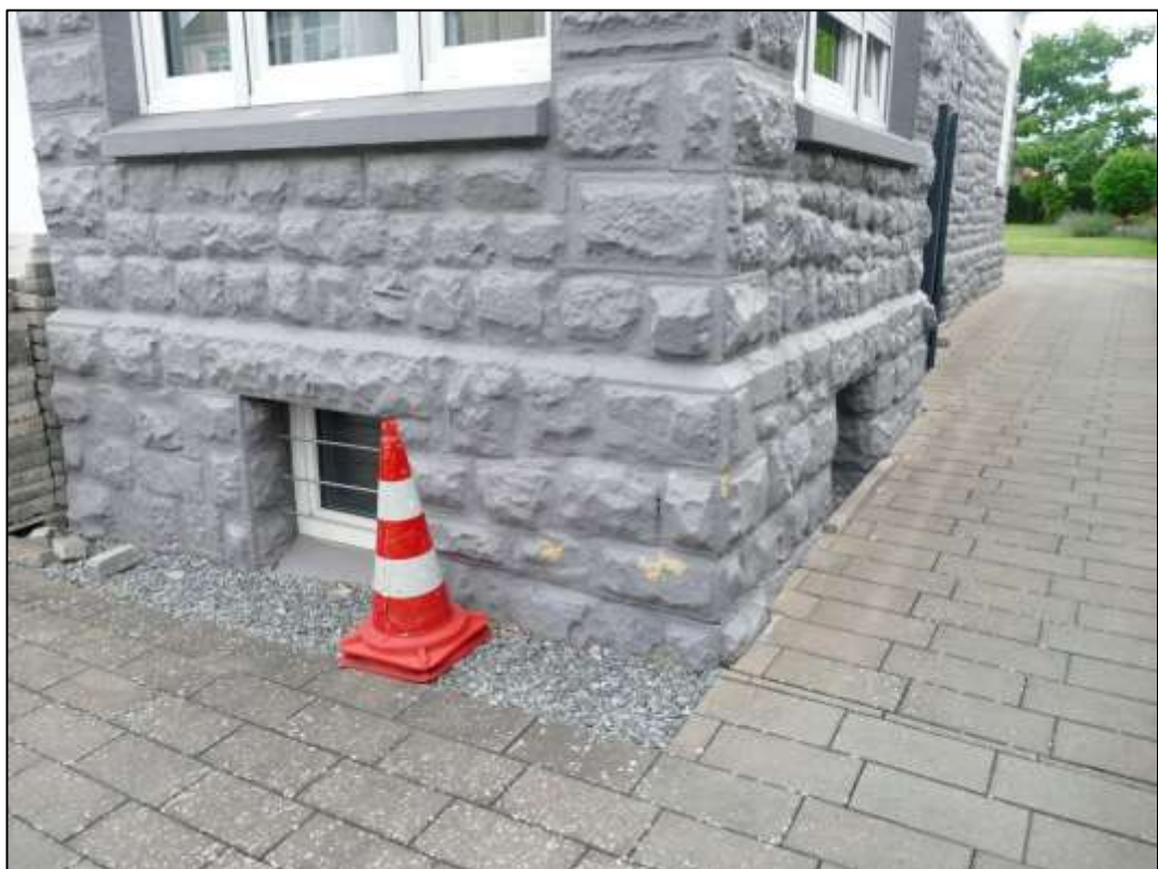
Sockelschaden Außenwand
