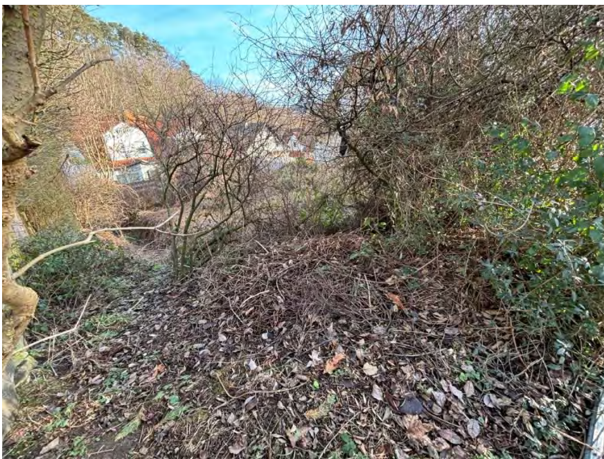
Straßenseitige Ansicht – Kellergeschoss mit Bewuchs
