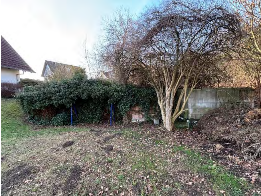
Ansicht von Norden – Kellergeschoss
