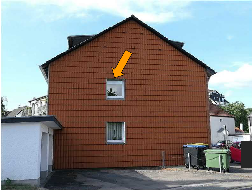
Straßenansicht von Süden (von der Paulshofstraße)
