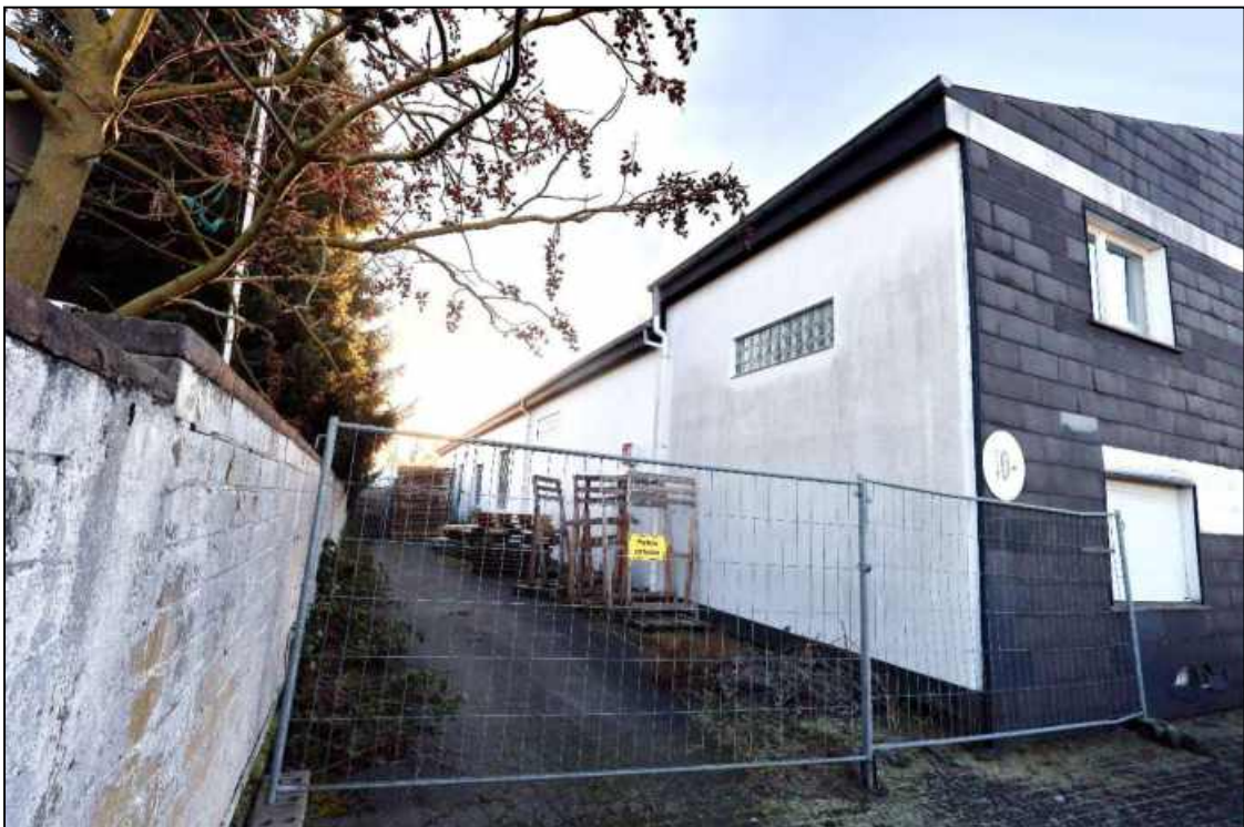
Abbildung 26 Seitenansicht der Lagerhalle mit Büroteil Foto Nr. 10, fotografiert am 20.02.2026
