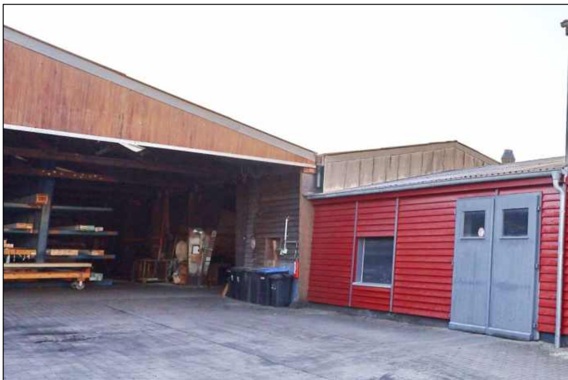
Abbildung 19 Straßenansicht der baulichen Anlage überdachte Lagerfläche (Mitte) Foto Nr. 7, fotografiert am 20.02.2026
