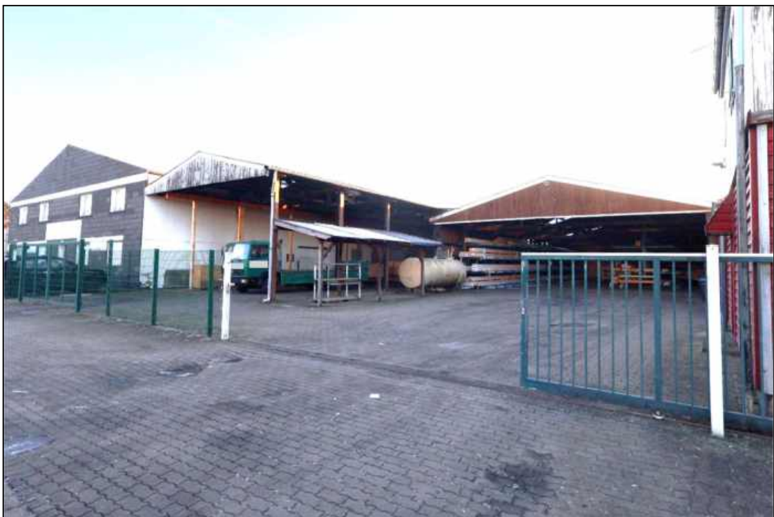
Abbildung 41 Zaunanlage als Hofsicherung Foto Nr. 20, fotografiert am 20.02.2026
