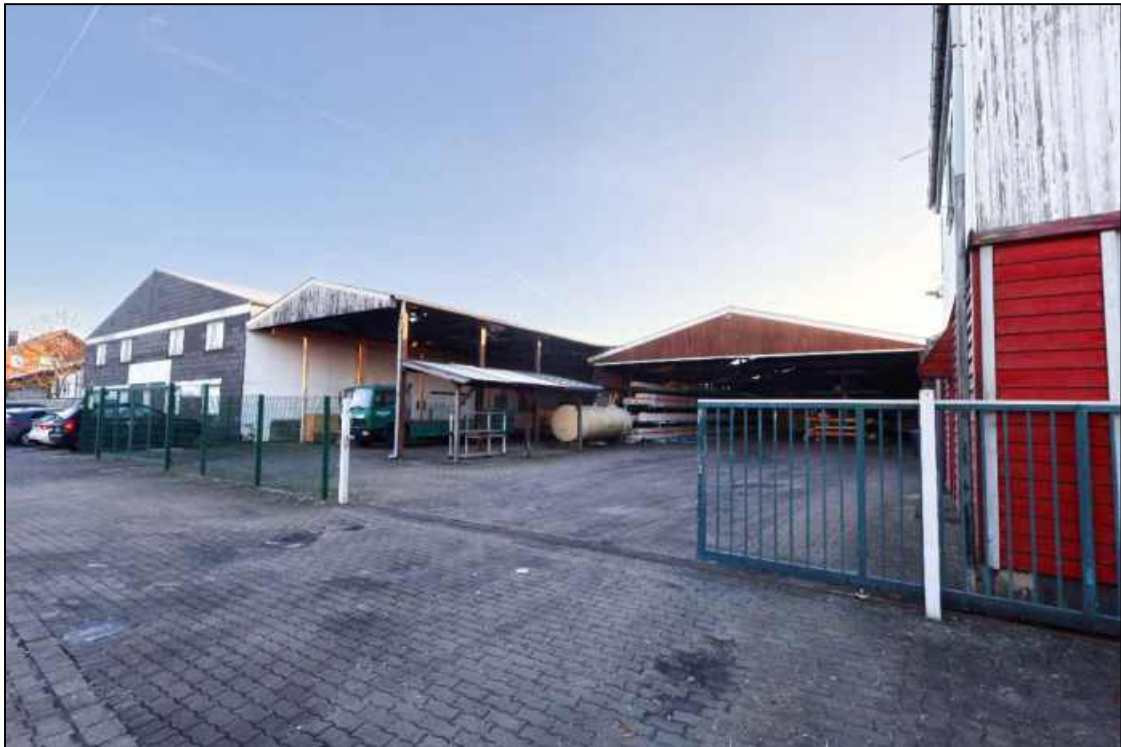
Abbildung 37 Gemischt nutzbare befestigte Freifläche, teils als Kfz-Stellplätze genutzt Foto Nr. 17, fotografiert am 20.02.2026
