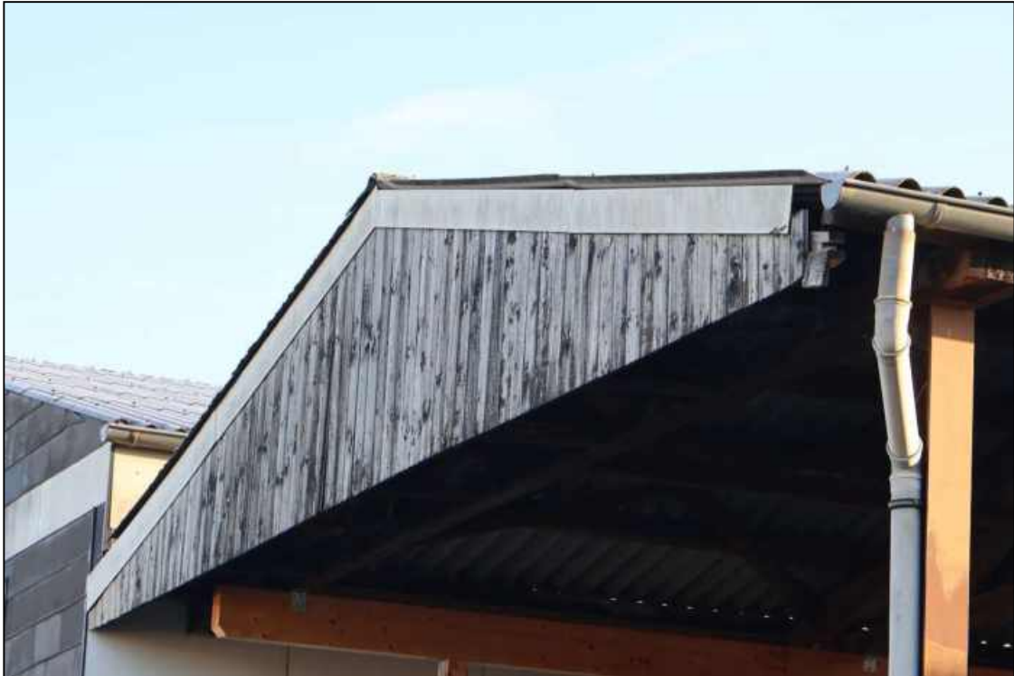
Abbildung 36 Abwitterung der Holzverkleidung des Giebels Foto Nr. 16, fotografiert am 20.02.2026
