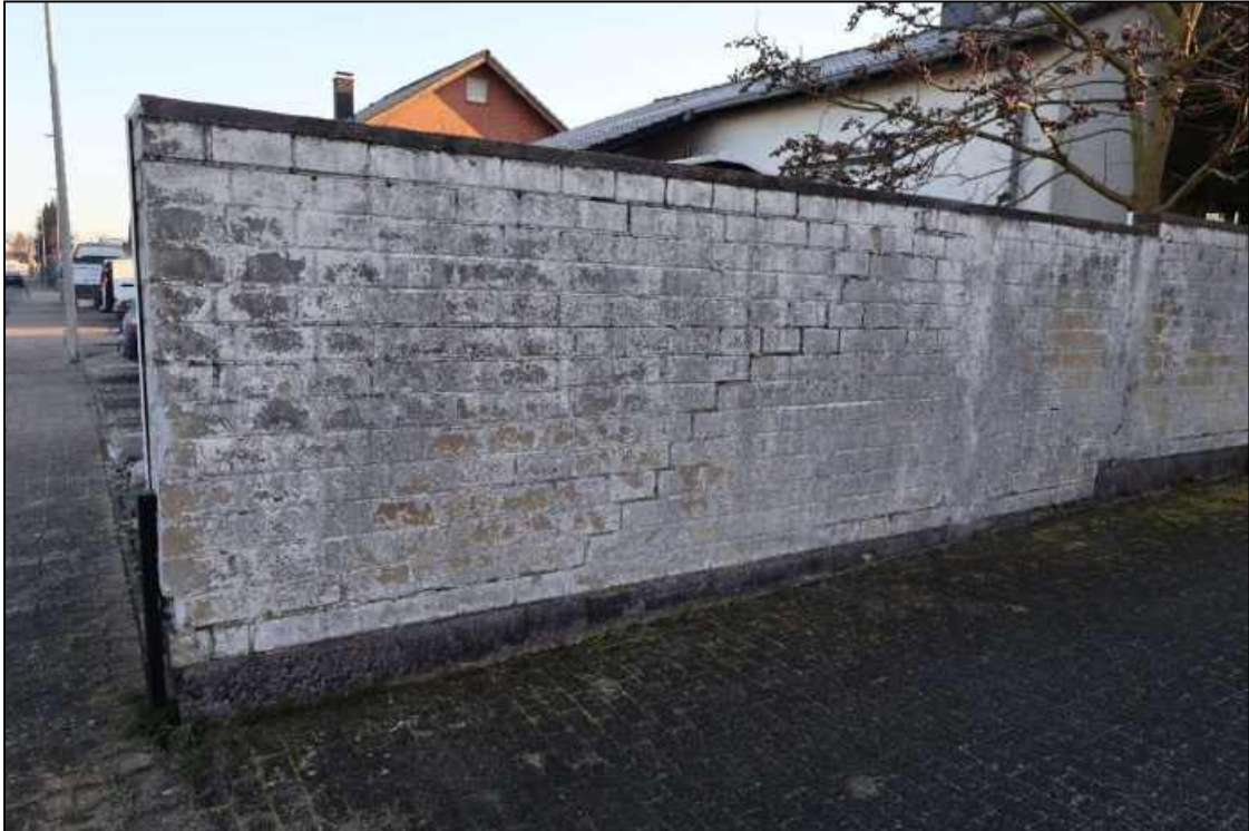
Abbildung 40 Mauer an der nordöstlichen Grundstücksgrenze Foto Nr. 19, fotografiert am 20.02.2026
