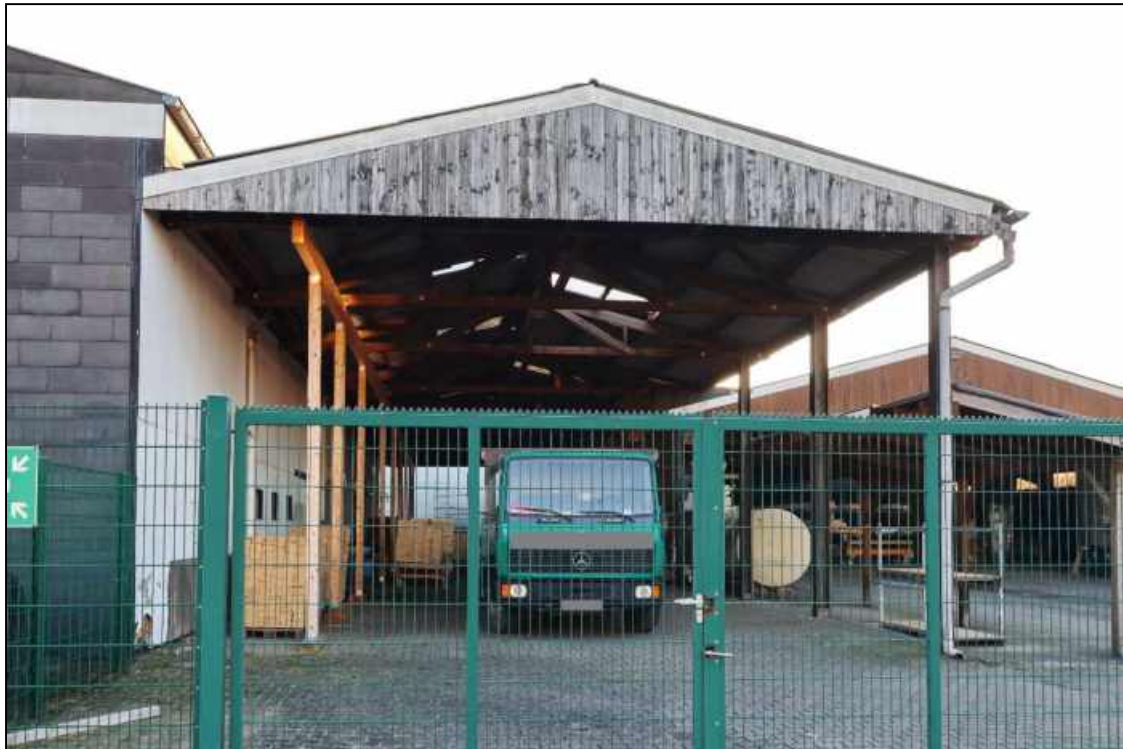
Abbildung 33 Straßenansicht der baulichen Anlage überdachte Durchfahrt Foto Nr. 15, fotografiert am 20.02.2026
