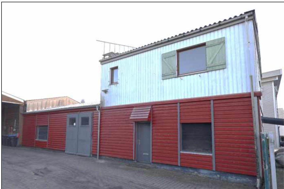
Abbildung 13 Seitenansicht der baulichen Anlage Büro- und Werkstattgebäude Foto Nr. 5, fotografiert am 20.02.2026
