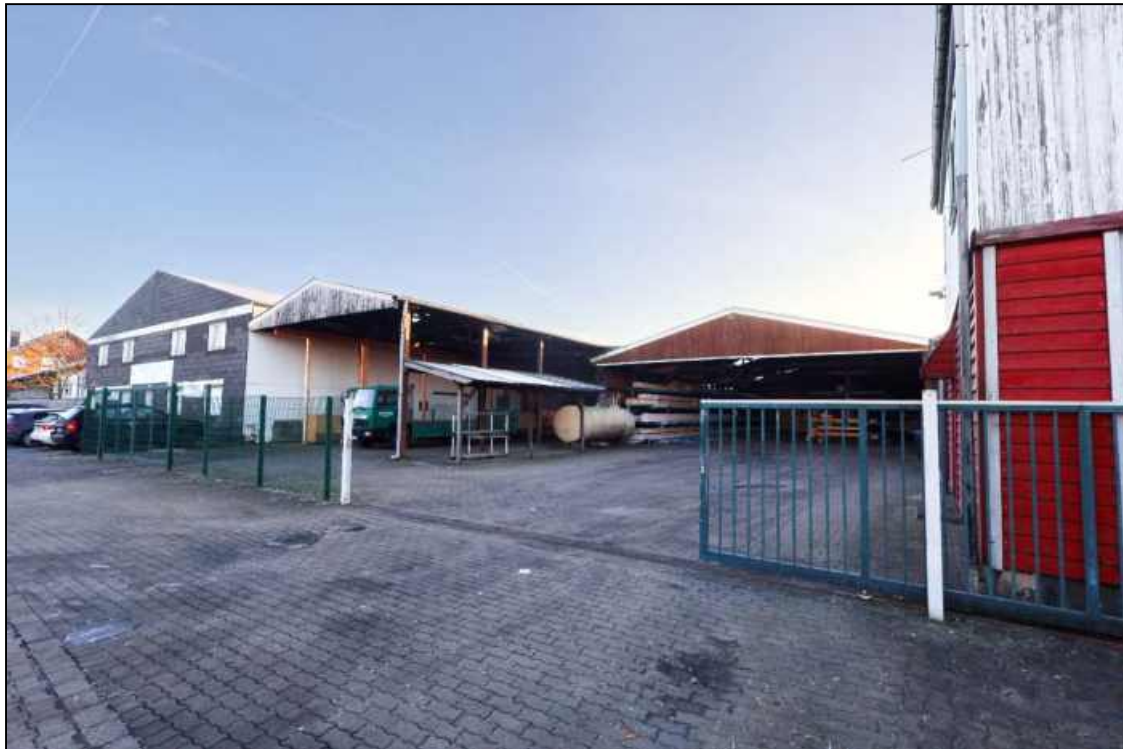
Abbildung 11 Straßenansicht der baulichen Anlagen Foto Nr. 3, fotografiert am 20.02.2026
