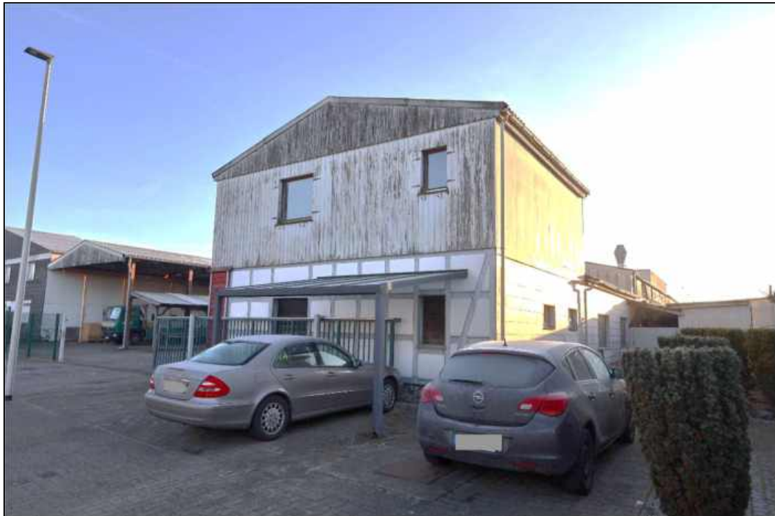
Abbildung 12 Straßenansicht der baulichen Anlage Büro- und Werkstattgebäude Foto Nr. 4, fotografiert am 20.02.2026
