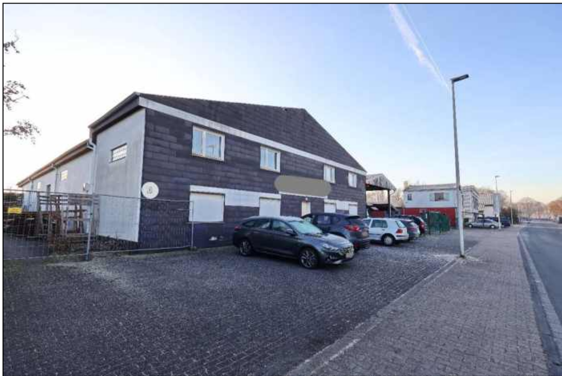
Abbildung 10 Straßenansicht der baulichen Anlagen Foto Nr. 2, fotografiert am 20.02.2026
