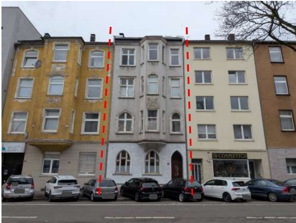
Ansicht Eingangsseite (Osten)
