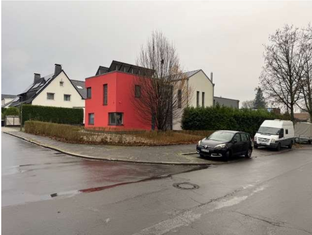
Ansicht von Nordosten
