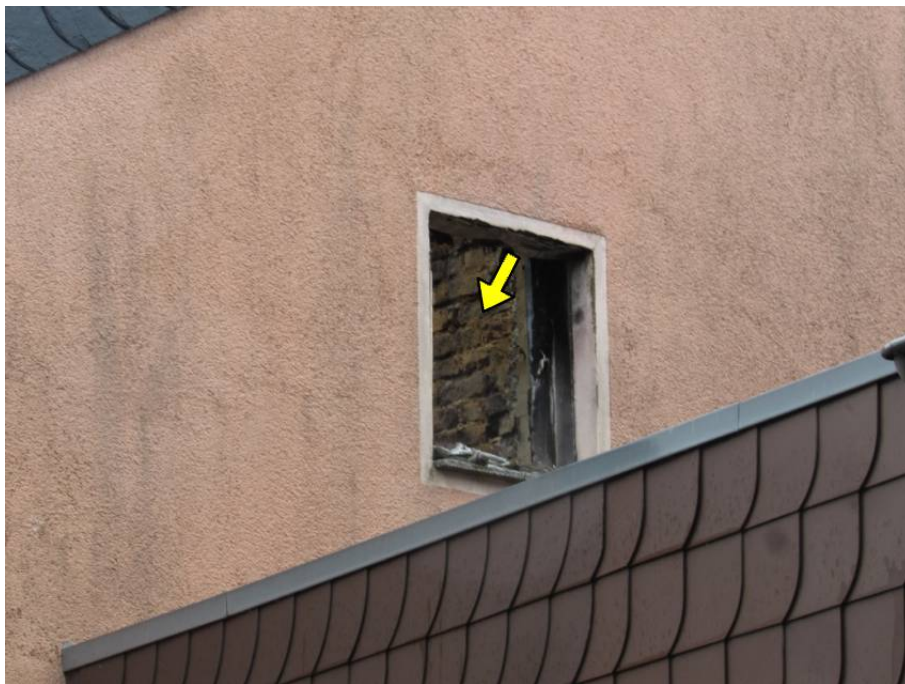
Foto 10: beschädigtes Mauerwerk
