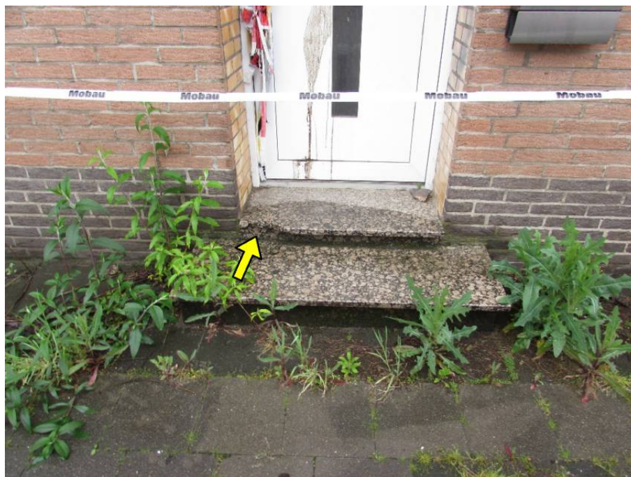
Foto 5: Beschädigtes Hauseingangspodest
