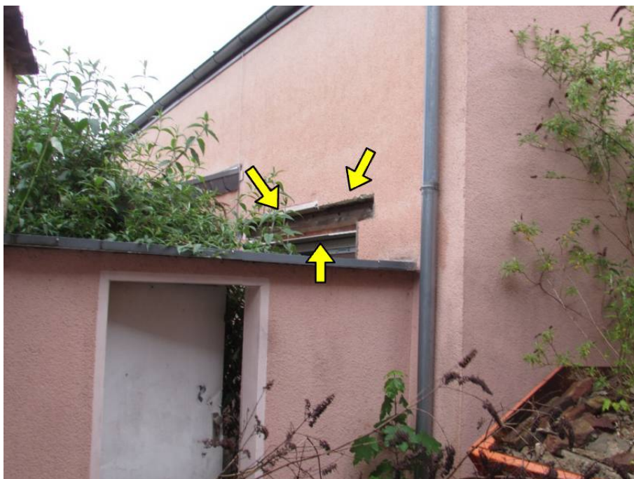
Foto 8: fehlender Rollladenkasten
