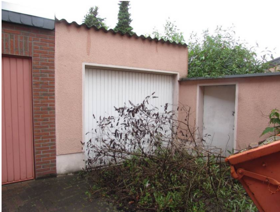
Foto 9: PKW-Garage und Metalltür zum Garten
