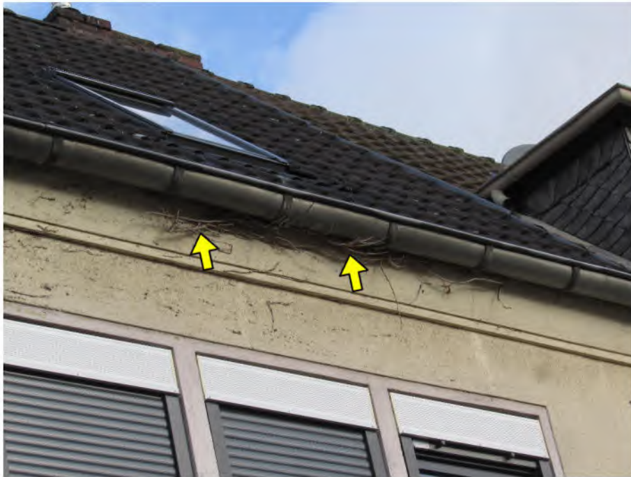
Foto 3: Wohnhaus: Reste einer Fassadeneingrünung
