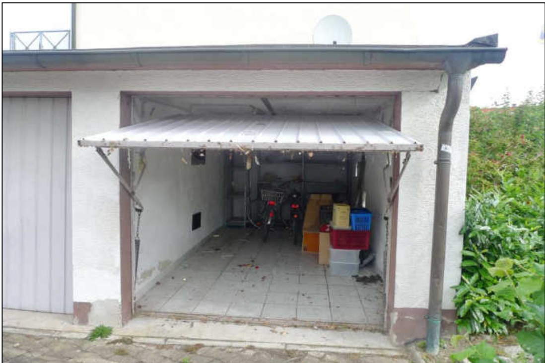
Abbildung 39 Innenansicht der baulichen Anlage Garage auf dem Flurstück 539 Die Garage auf dem zu bewertenden Grundstück Flurstück 537 konnte nicht von innen besichtigt werden. fotografiert am 11.06.2025
