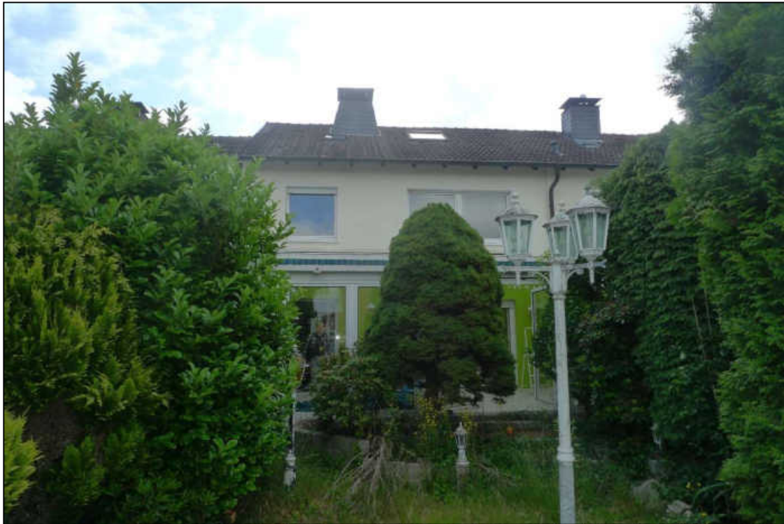
Abbildung 9 Rückansicht der baulichen Anlage Reihenmittelhaus fotografiert am 11.06.2025
