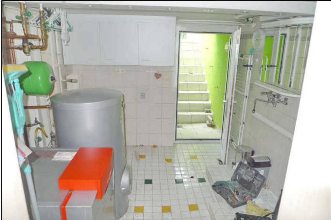
Abbildung 12 Heizungs- und Waschraum im Kellergeschoss mit Zugang zum Wintergarten fotografiert am 11.06.2025
