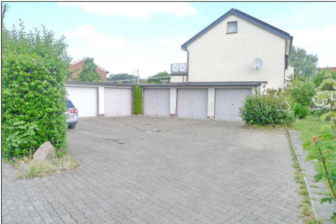
Abbildung 40 Garagenhof und Zufahrt auf dem Flurstück 499 fotografiert am 11.06.2025
