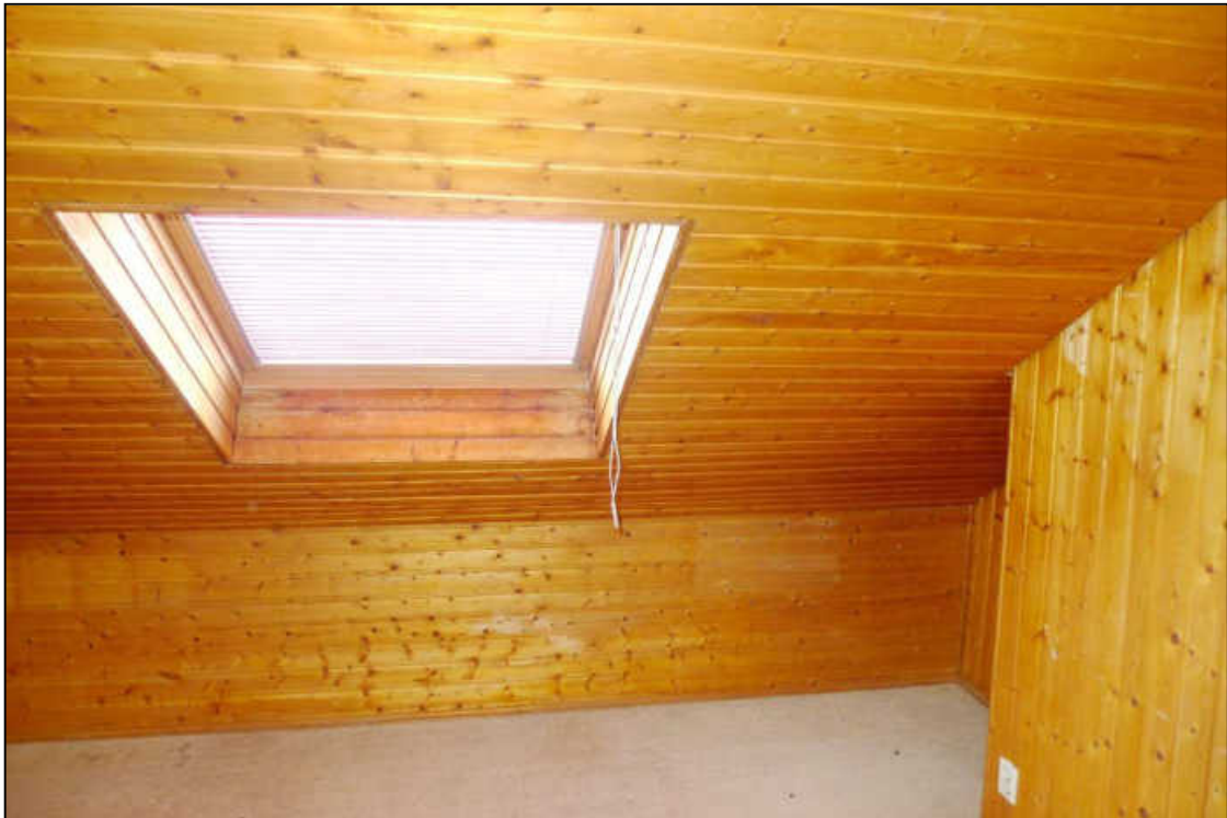
Abbildung 30 Abstellraum im Dachgeschoss fotografiert am 11.06.2025
