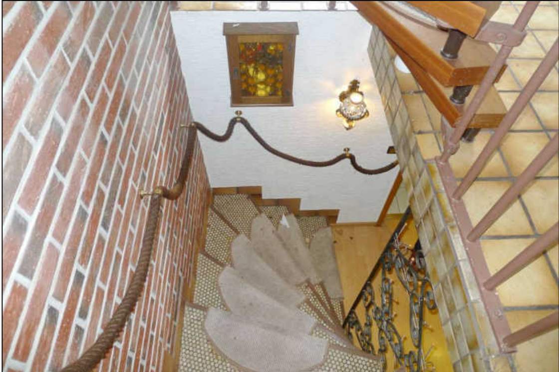
Abbildung 10 Treppe zum Kellergeschoss fotografiert am 11.06.2025
