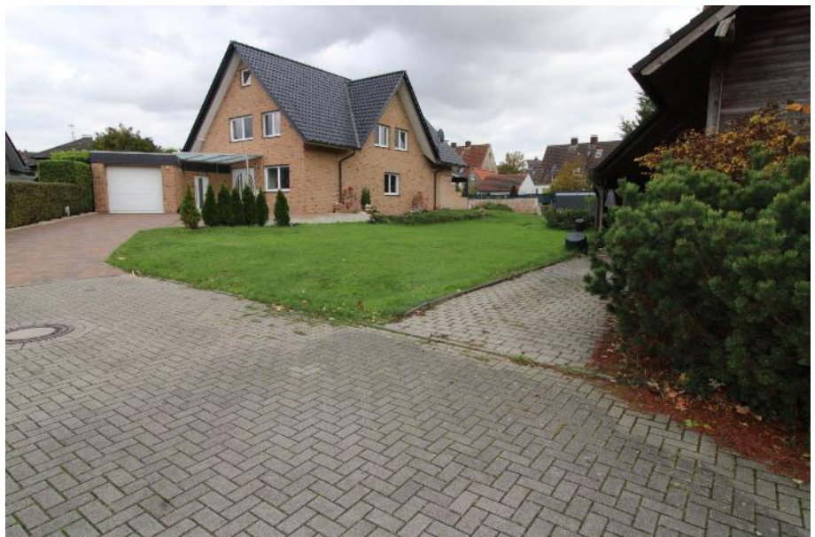
Sicht von der Zufahrt Platanenring auf das zu bewertende ge- pflasterte Flurstück 573 sowie das unbe- baute Flurstück 680
