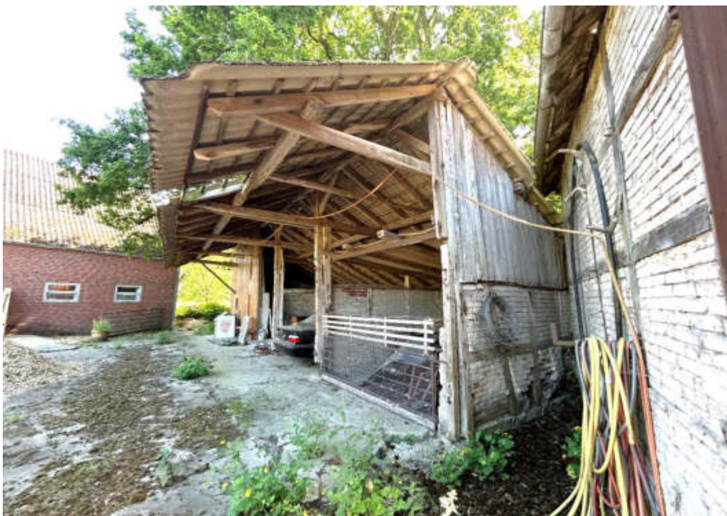
Remise von Nordwesten
