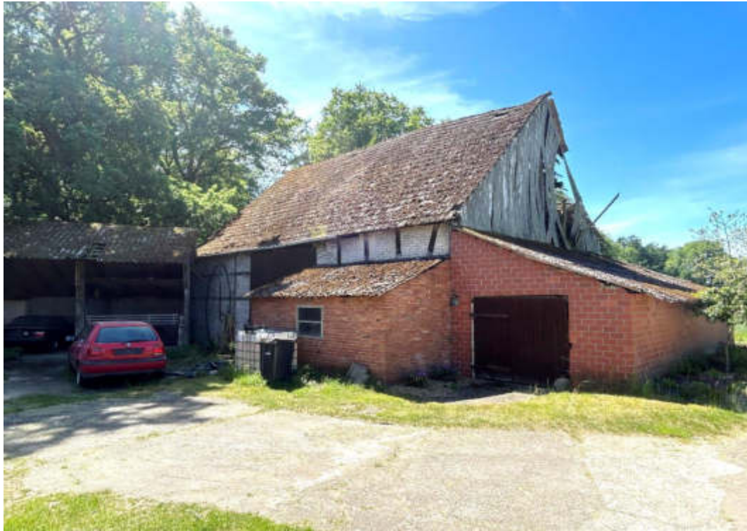
Ehemalige Scheune von Nordosten
