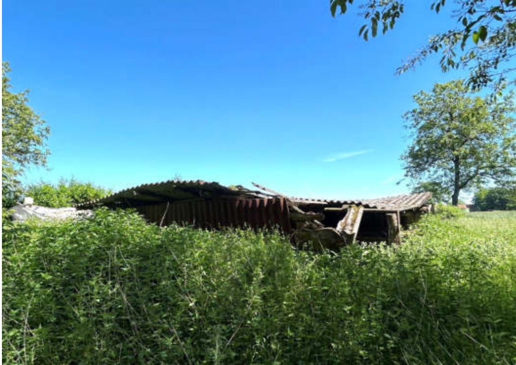
Ehemaliger Hühnerstall von Südwesten
