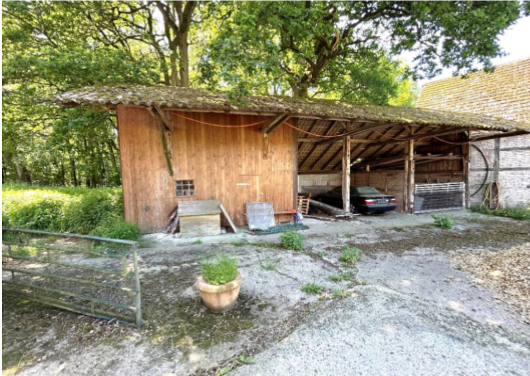
Remise von Norden
