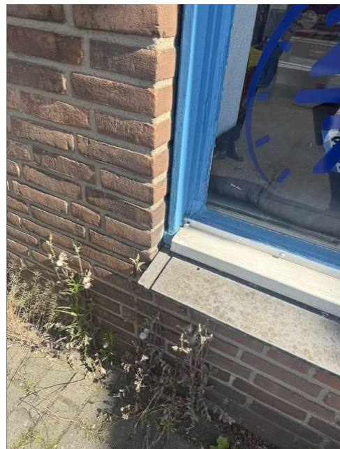
Bild 8: Bewuchs an der Hausfassade (repräsentativ)
