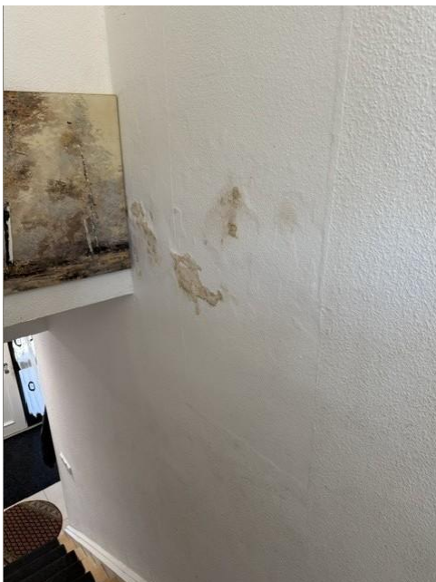
Bild 11: Feuchtigkeit (Treppenhaus)
