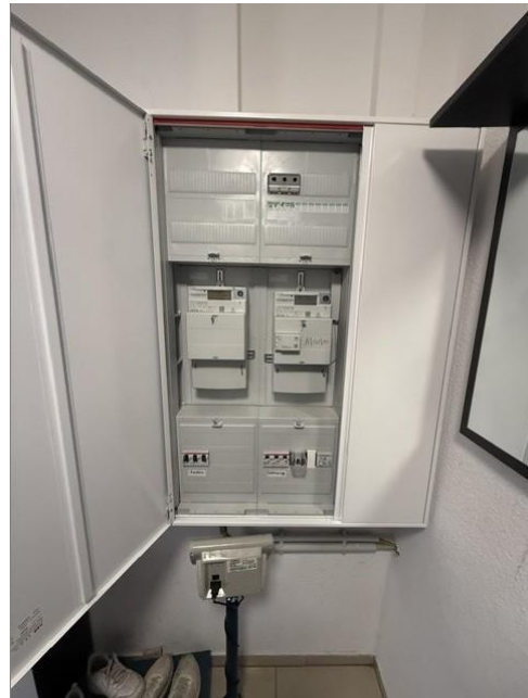
Bild 10: Zählerschrank
