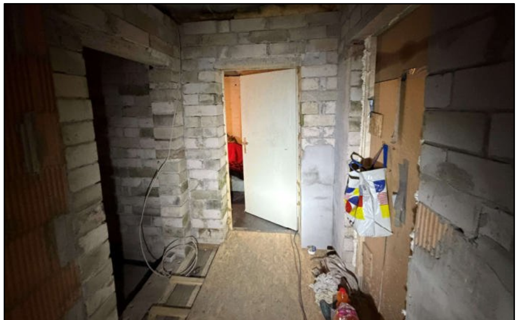
rückwärtiger Flur im Rohbauzustand (Bereich der ehemaligen Schlosserei)
