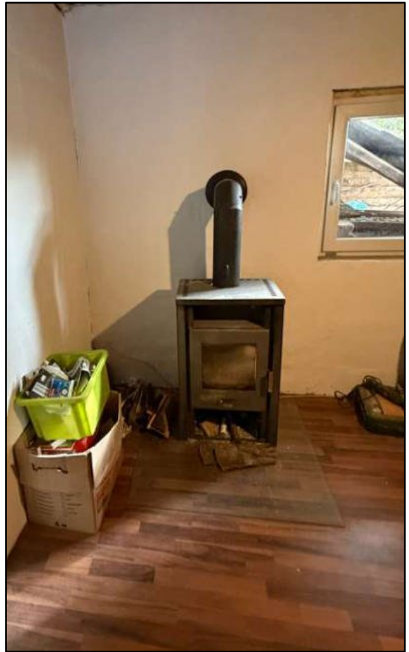
rechts der provisorische Aufenthaltsraum
