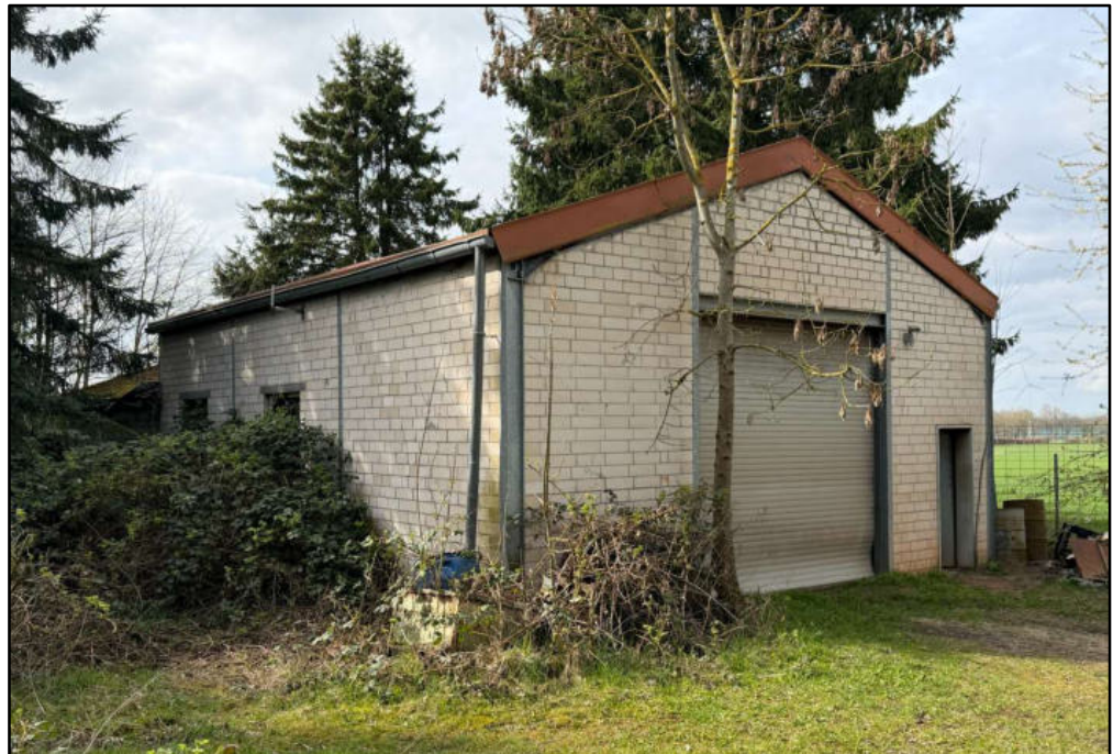
Südostansicht, Werkstattanbau, Stahlträgerkonstruktion mit Kalksandsteinausmauerung
