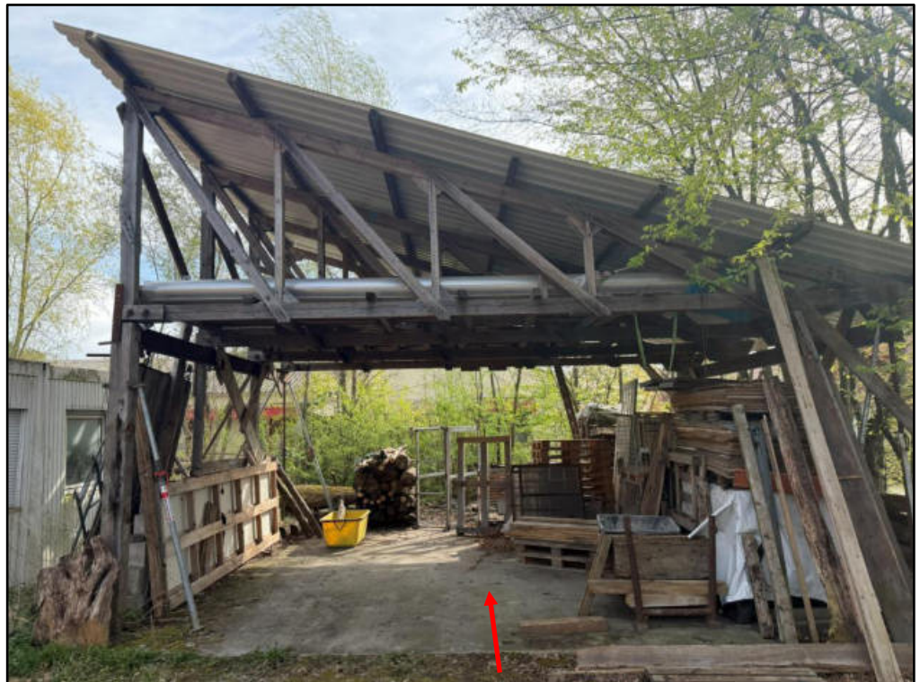
maroder, mit Baustützen abgestützter Offenschuppen mit Pulldach, bebaute Fläche rd. 6,0 x 7,50 m
