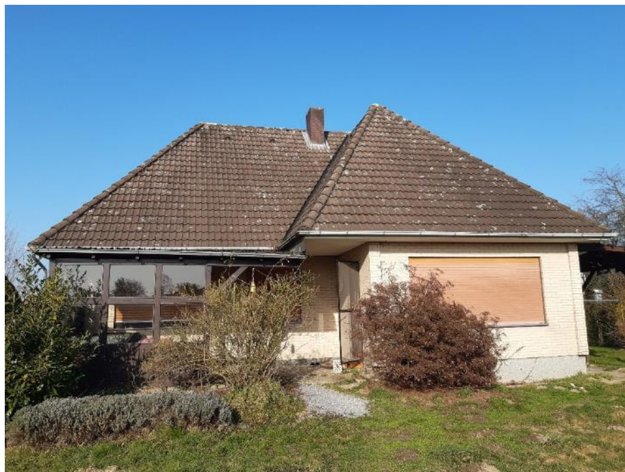
Südwestansicht (Gartenansicht) des Einfamilienhauses
