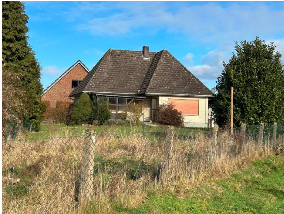
Südwestansicht des Einfamilienhauses
