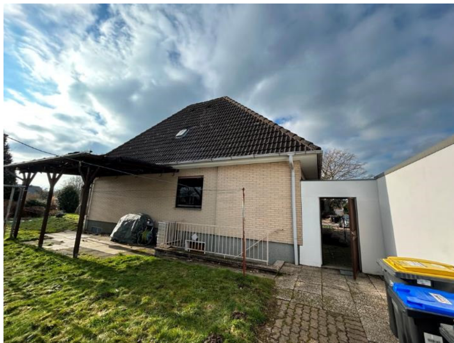
Ostansicht (Rückansicht) des Einfamilienhauses mit Garage
