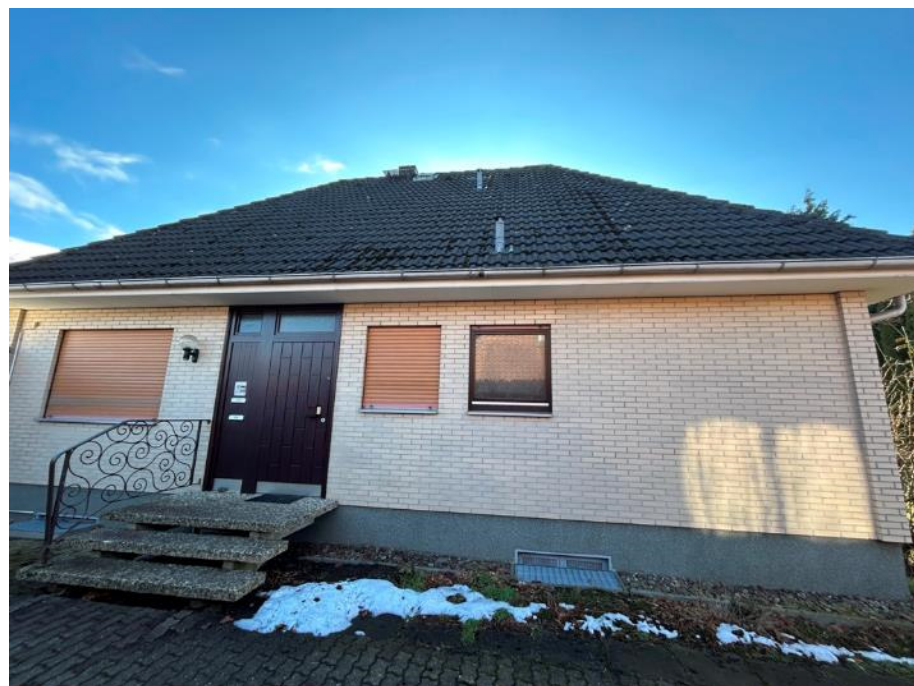
Nordansicht des Einfamilienhauses
