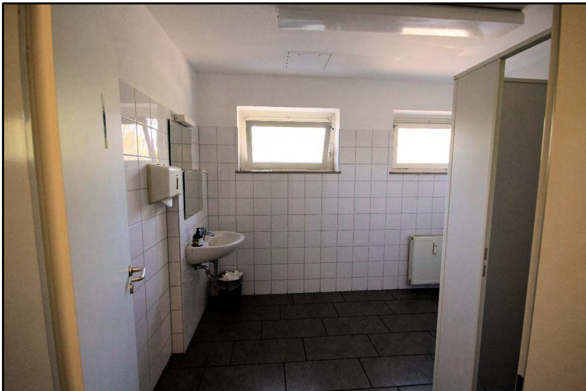
Bild 21: WC-Herren des Imbissbetriebes im Erdgeschoss
