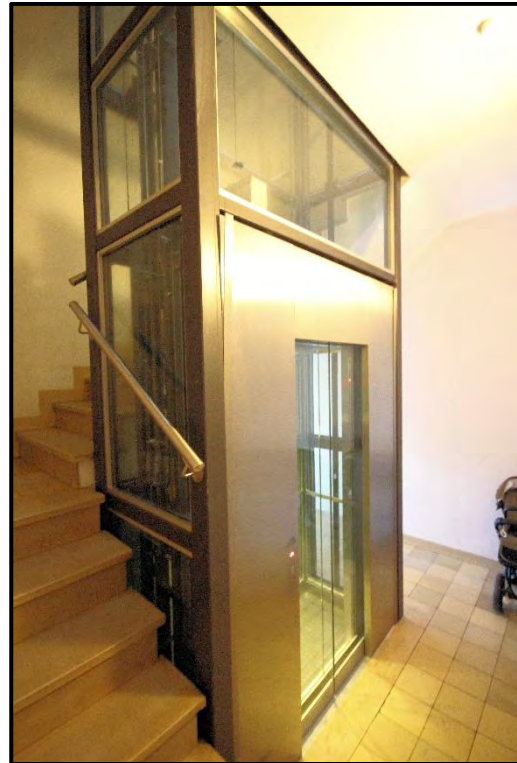
Bild 13: nachträglich eingebauter Aufzug
