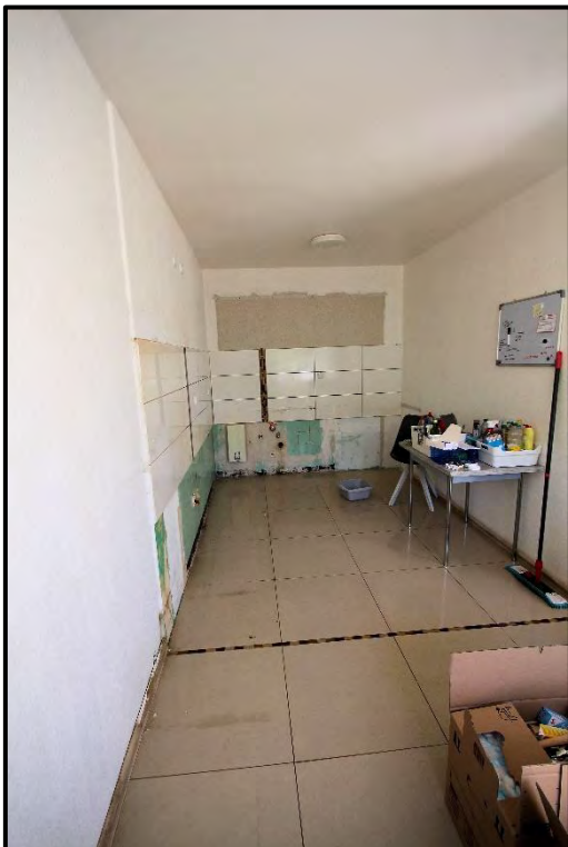
Bild 32: Küche der Wohneinheit im 1. OG rechts
