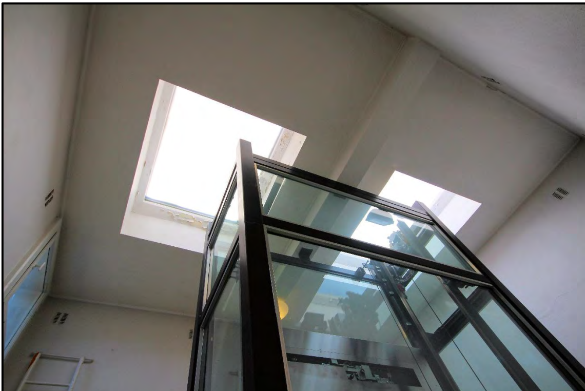
Bild 14: Aufzugkopf und Dachlichtkuppeln im Dachgeschoss
