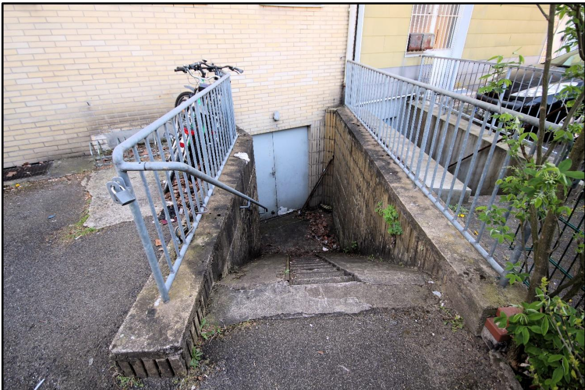
Bild 8: Kelleraußentreppe an der Nordseite
