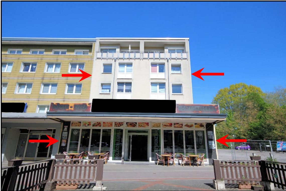
Bild 3: Ansicht von Süden
