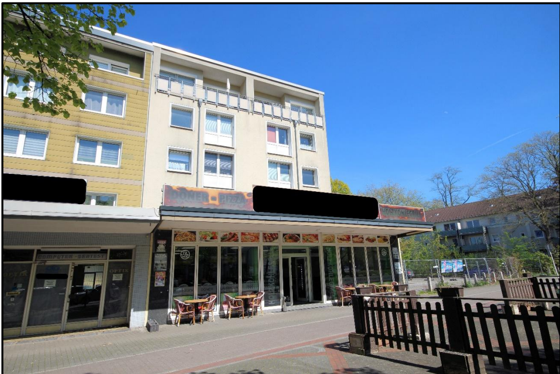
Bild 2: Ansicht von Südwesten
