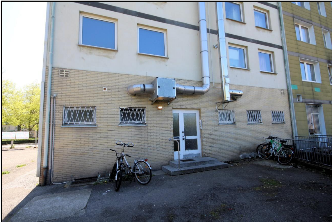
Bild 7: Hauseingang an der Nordseite
