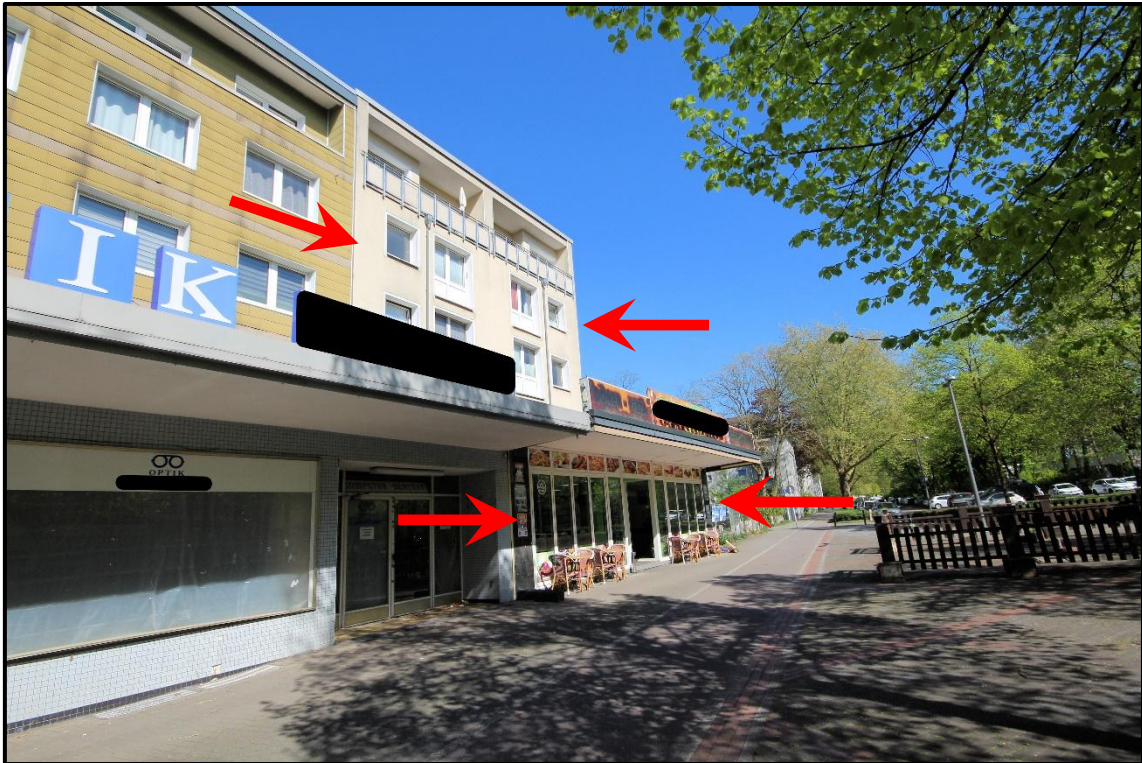
Bild 1: Ansicht von Westen
