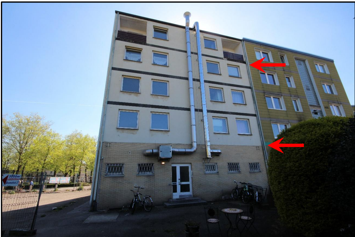
Bild 6: Ansicht von Norden
