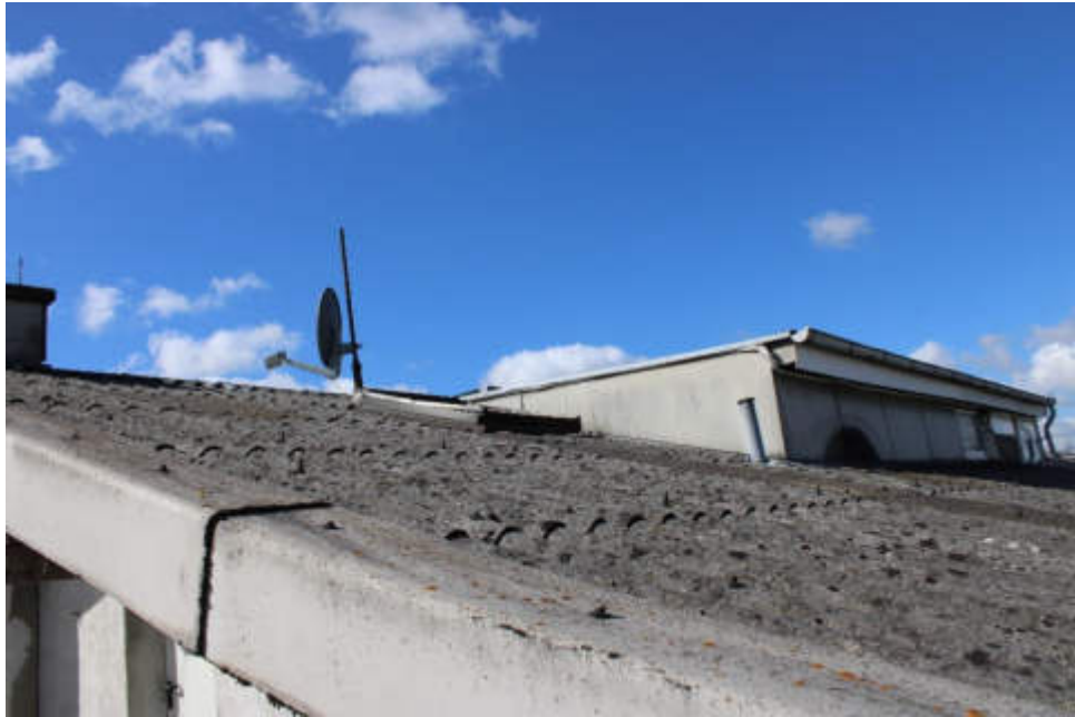
Bild 73: Übersicht Dachfläche / Dachaufbau Aufzugschacht
