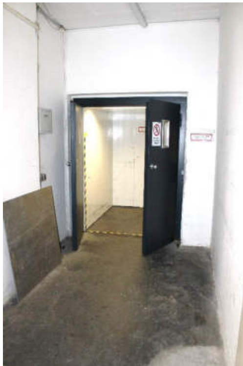
Bild 28: Verkehrsflächen Erdgeschoss / Aufzuganlage
