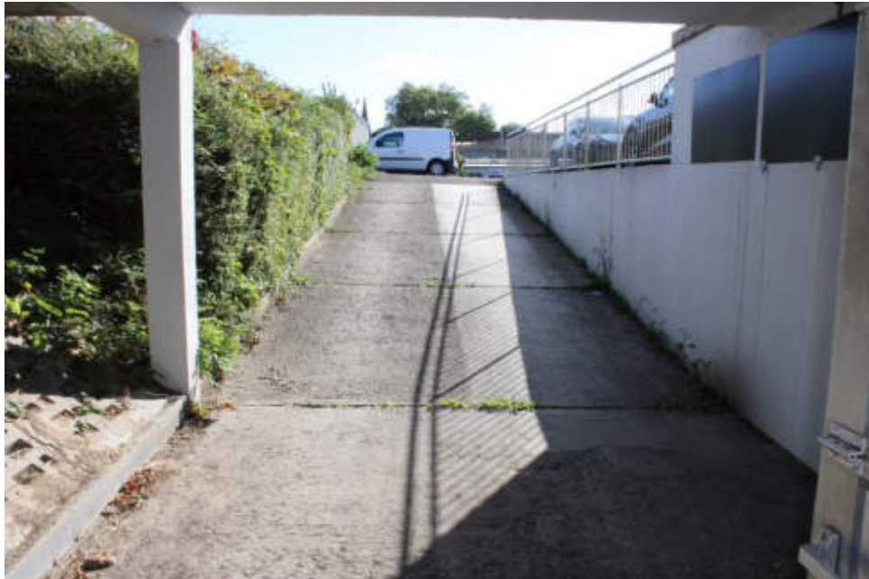
Bild 11: seitliche Zufahrtfläche zum Kellergeschoss
