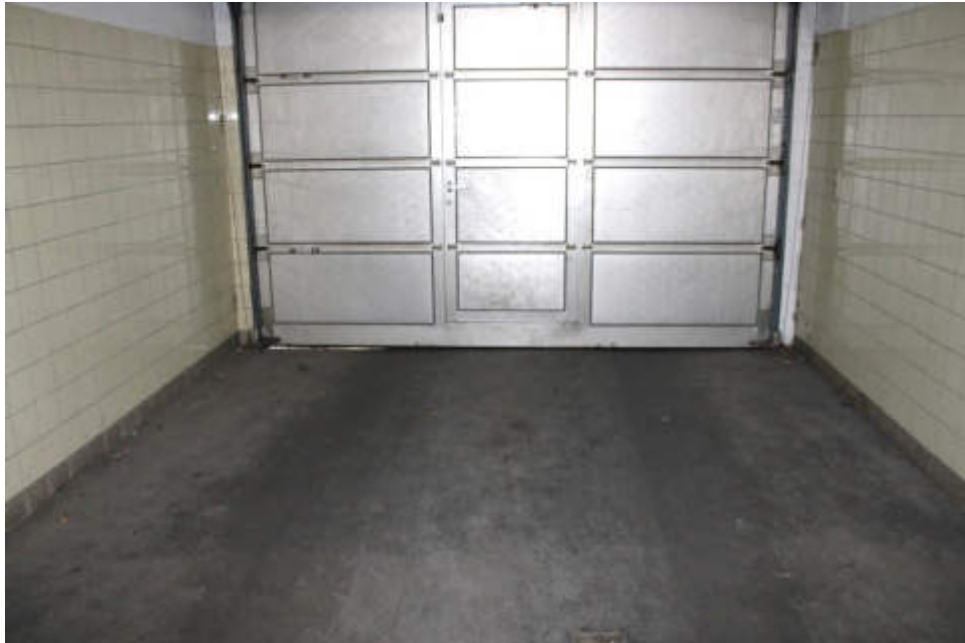
Bild 13: Anlieferung / Verkehrsfläche Kellergeschoss
