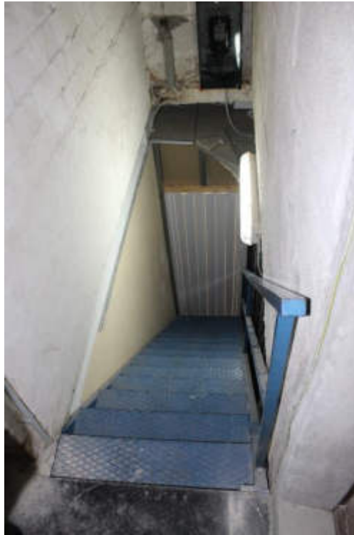
Bild 57: Treppe zur Aufzuganlage / Wartungsraum
