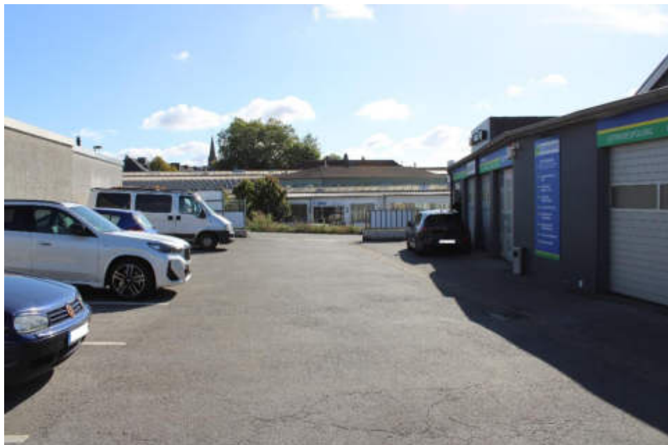
Bild 4: Hoffläche und Kfz-Stellplätze / Nordostansicht des Werkstattgebäudes
