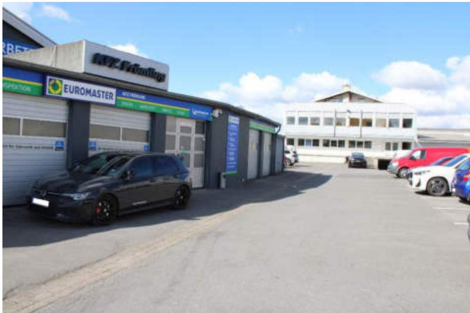
Bild 8: Nordostansicht Werkstattgebäude / Südostansicht Büro- und Lagergebäude
