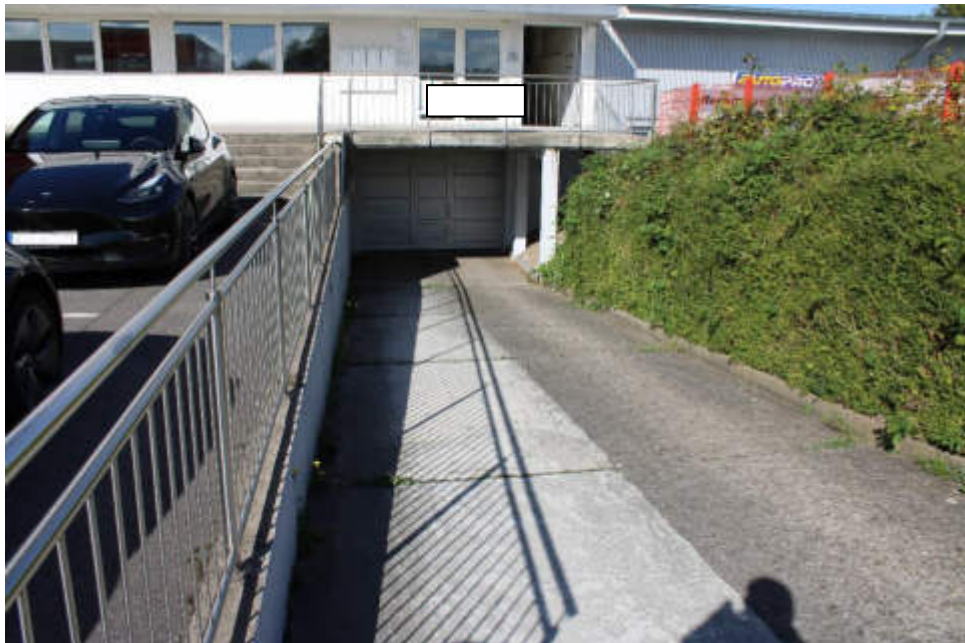
Bild 12: seitliche Zufahrtfläche zum Kellergeschoss
