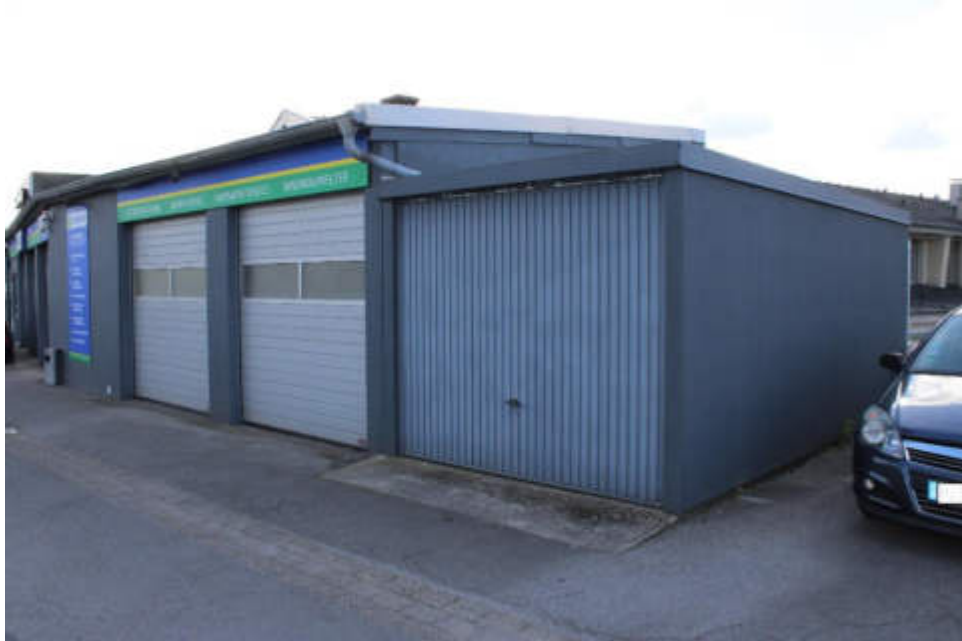
Bild 9: Nordostansicht Werkstattgebäude / Nordostansicht und Nordwestansicht Garage
