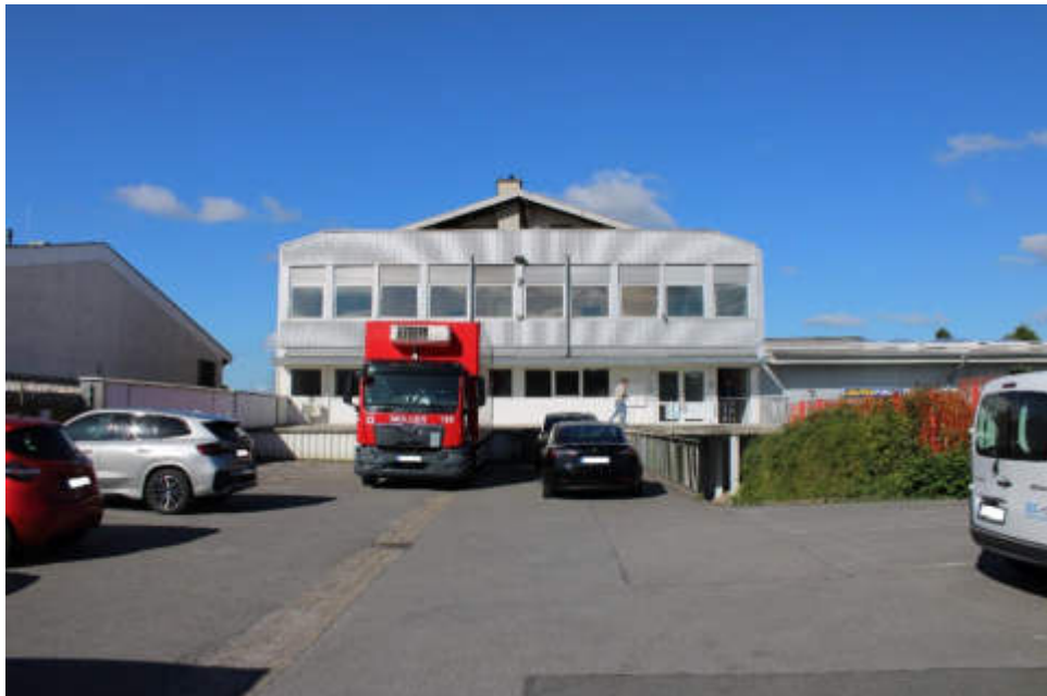
Bild 10: Südostansicht Büro- und Lagergebäude
