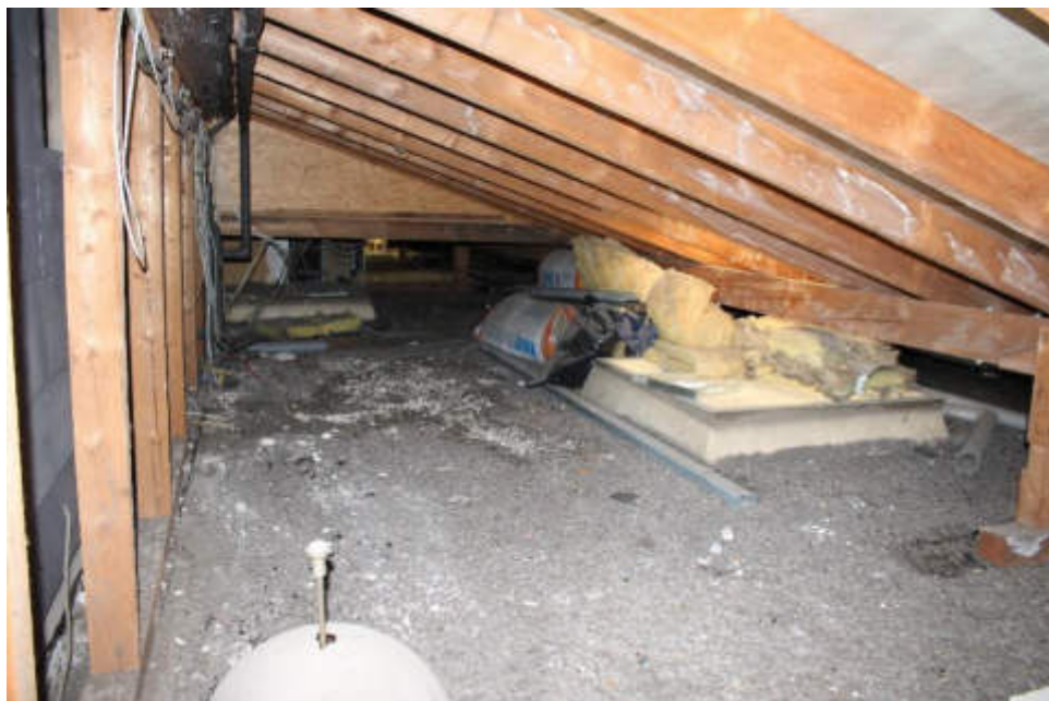
Bild 72: Abraum DG / Dachkonstruktion
