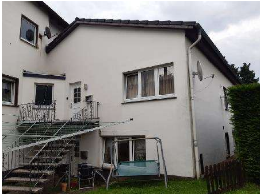
Westansicht (Straßenansicht von der Straße „Schloßberg“) des Mehrfamilienhauses
