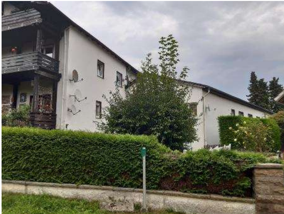
Südwestansicht (Straßenansicht von der Straße „Schloßberg“) des Mehrfamilienhauses
