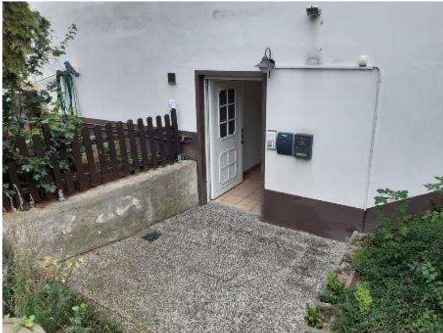
Ostansicht des Hauseingangs zur Eigentumswohnung im Souterrain des Anbaus
