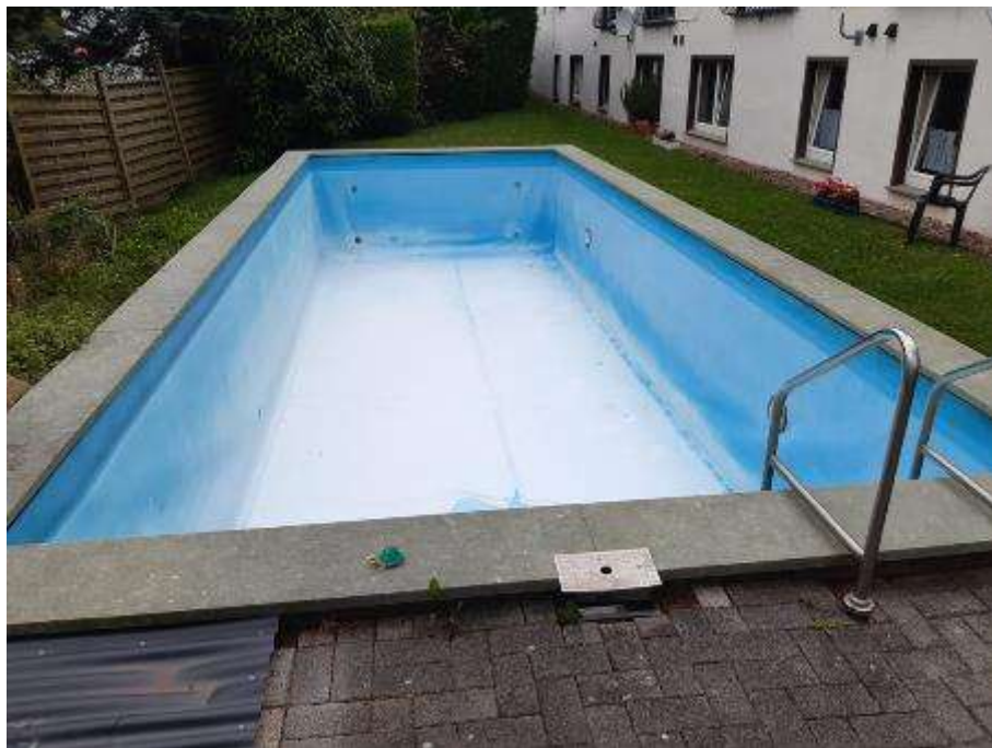
Ostansicht des Pools
