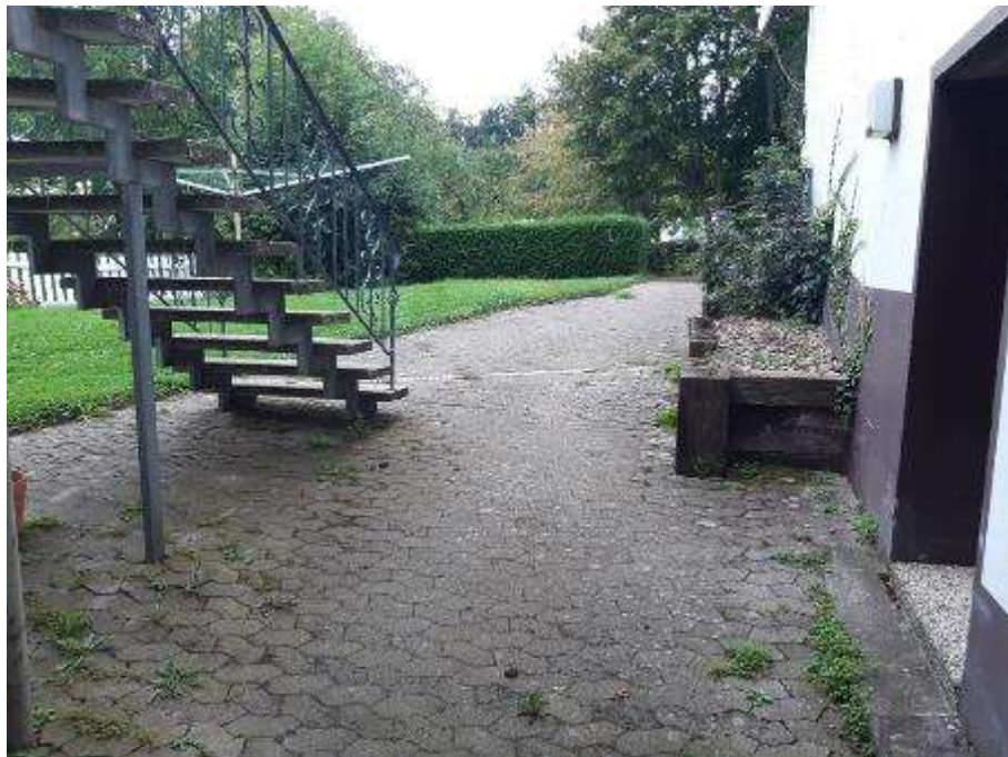
Nordwestansicht der Zuwegung zur Straße „Schloßberg“
