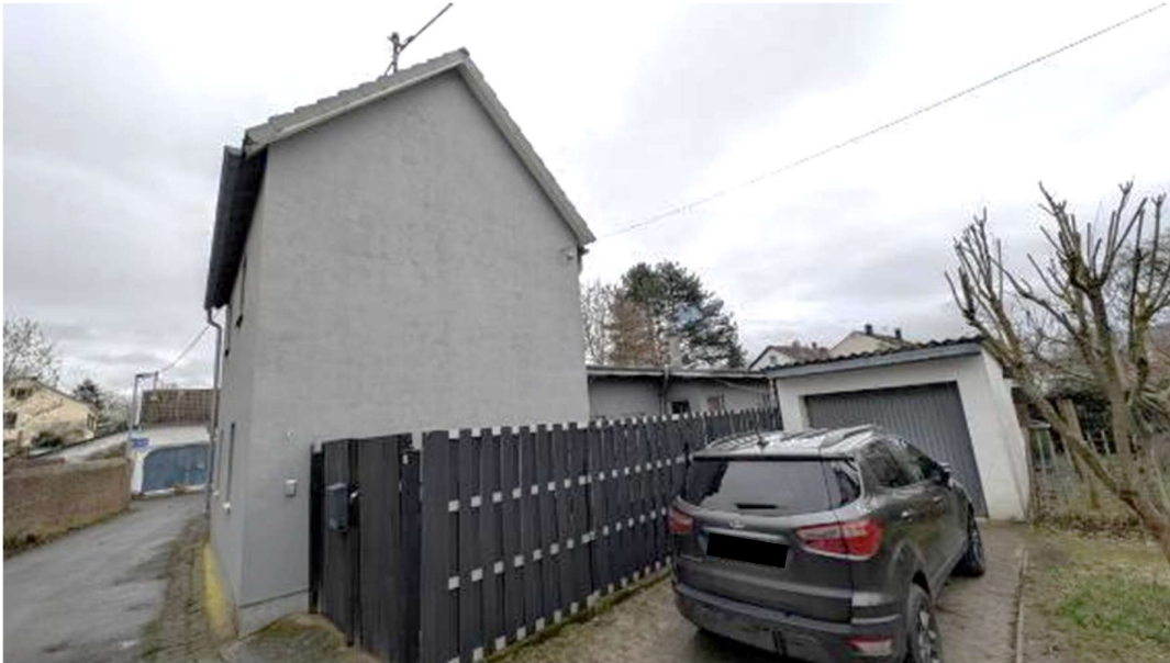
Bild B2 exemplarische Gebäudeansicht – Blick von Norden
