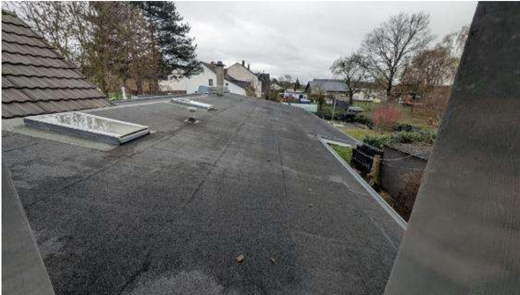
Bild B8 Dachansicht Anbau
