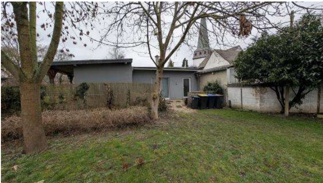
Bild B3 exemplarische Gebäudeansicht – Blick von Osten
