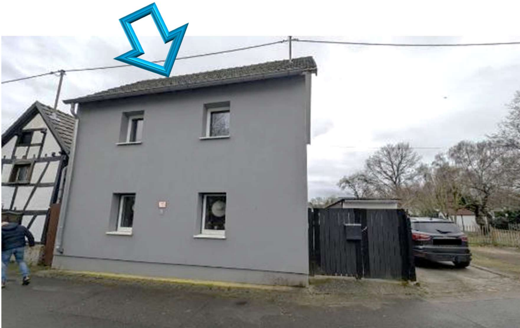
Bild B1 exemplarische Gebäudeansicht – Blick von Norden
