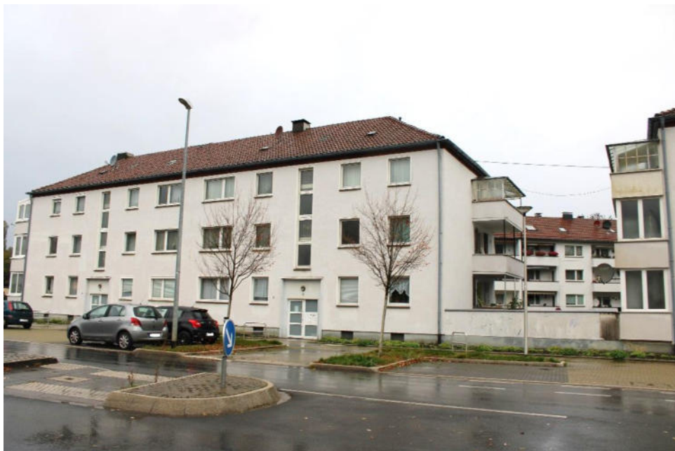
Bild 4: Straßenansicht / Südostansicht Gebäude 170 u. 168
