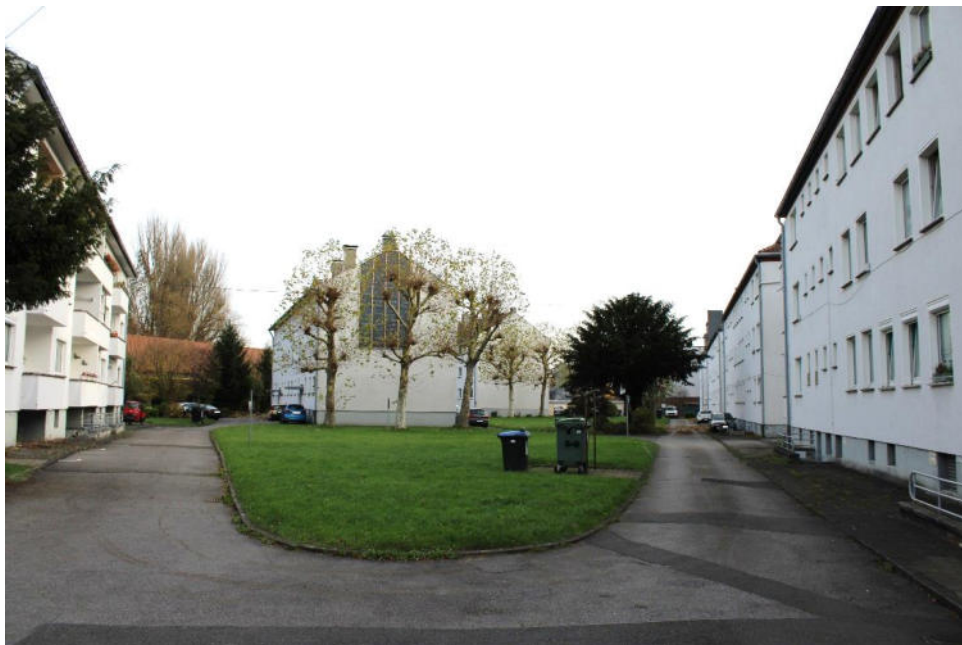
Bild 8: rückseitige Wege- und Stellplatzflächen
