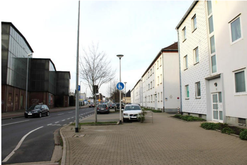
Bild 1: Umgebungsbebauung Richtung Südwesten
