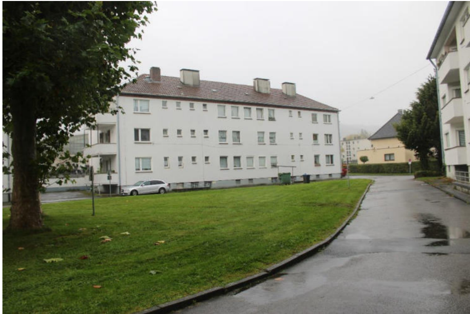
Bild 9: Rückansicht / Nordwestansicht Gebäude 168 u. 170
