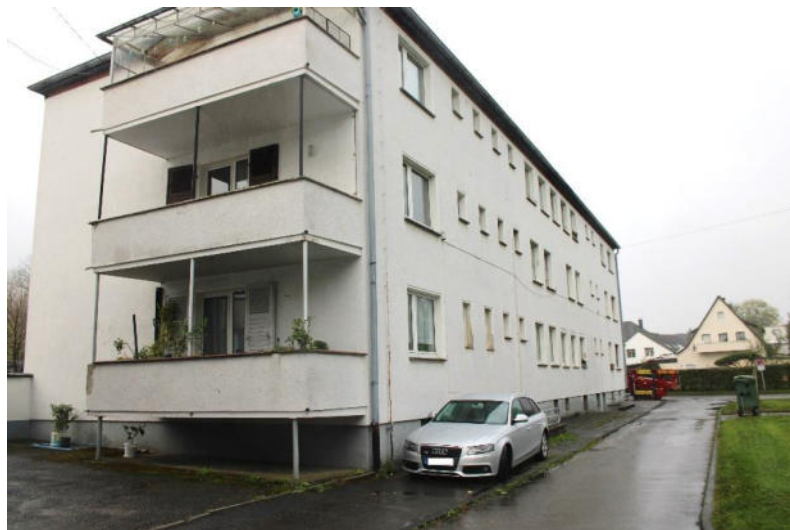
Bild 6: Nordostgiebel Gebäude 168 und Rückansicht / Nordwestansicht Gebäude 168 u. 170
