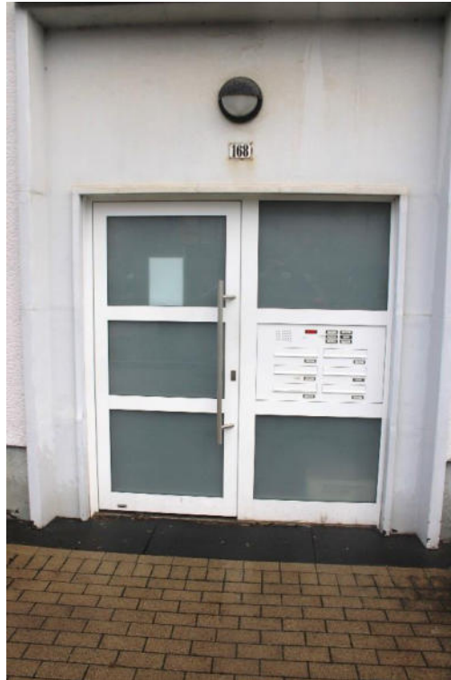
Bild 5: Hauseingang Haus Nr. 168
