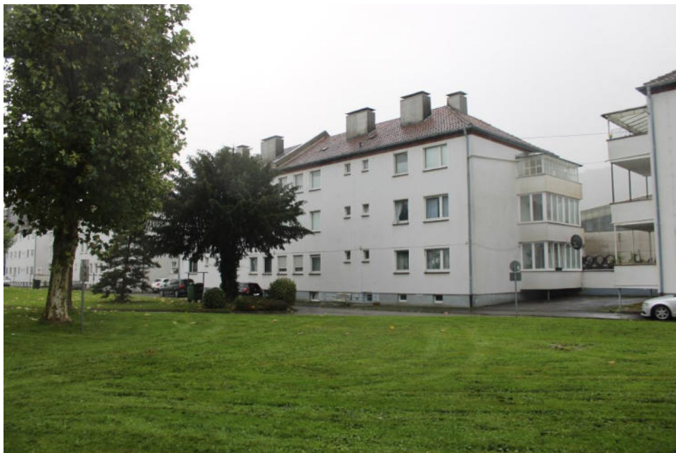
Bild 10: Rückansicht / Nordwestansicht und Südwestgiebel Gebäude 166
