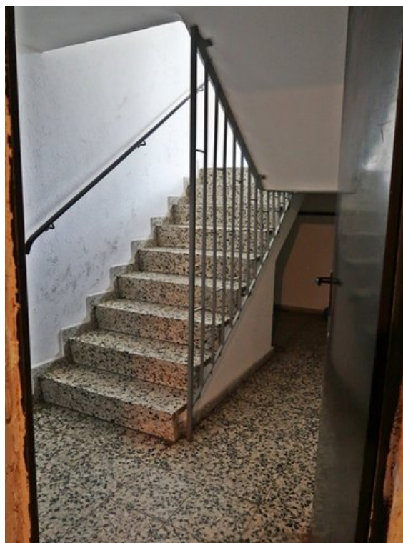
Treppe zum Kellergeschoss
