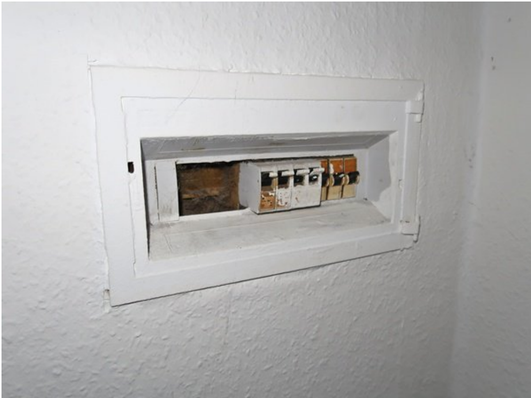
Elektrounterverteilung
