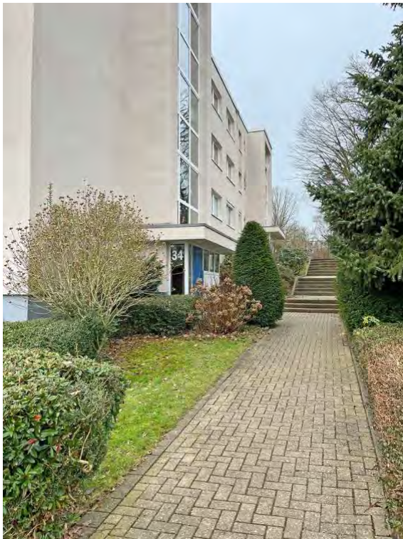
Zugang zu Amyastraße 34 und 36 in Richtung Westen
