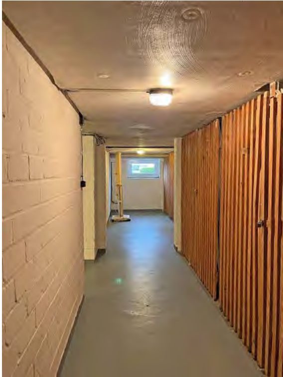
Kellerflur mit Abstellkellern
