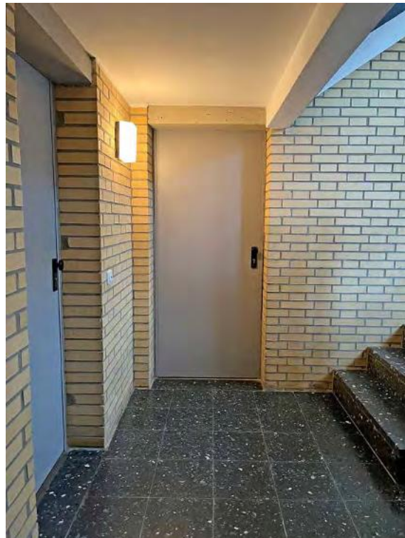
Treppenhaus im Kellergeschoss
