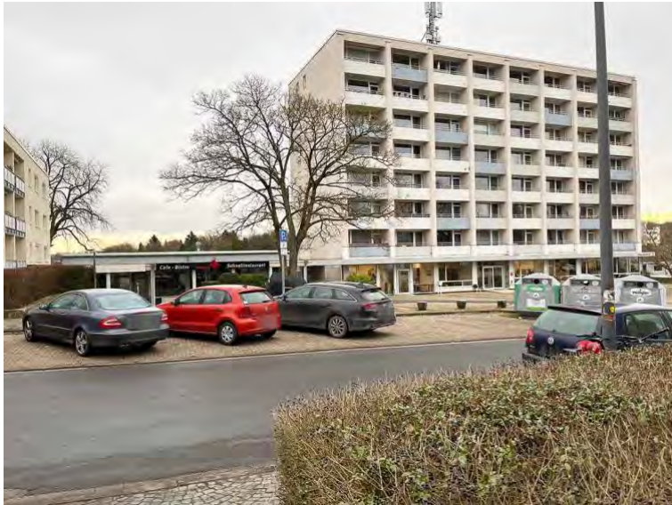
Amystraße 43 mit sanierungsbedürftigem Vorplatz
