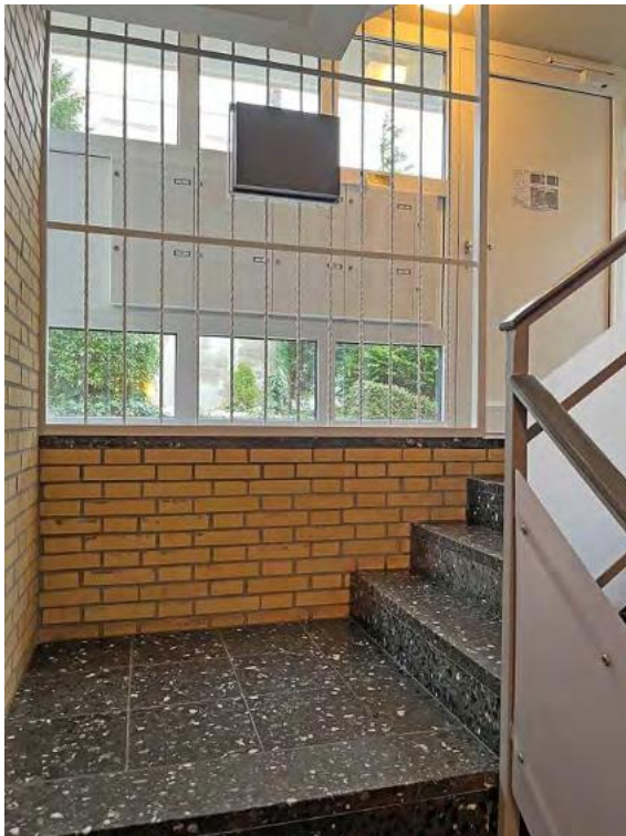
Hauseingang und Kellertreppe Amyastr. 34
