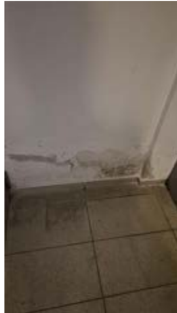
Bild 10: Feuchtigkeitsschäden Treppenhaus
