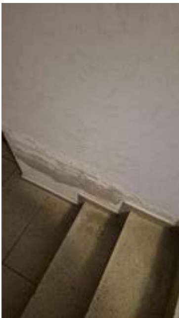
Bild 11: Feuchtigkeitsschäden Treppenhaus
