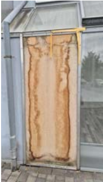
Bild 9: defekte Schaufensterscheibe
