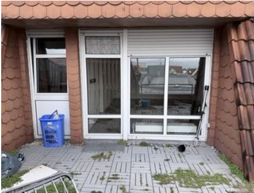
Blick auf das Küchenfenster und Fenster des Wohnbereichs
