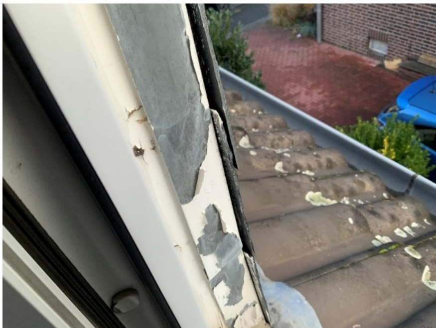
Bild 20: Anstrichablösungen Dachgauben-Fenster
