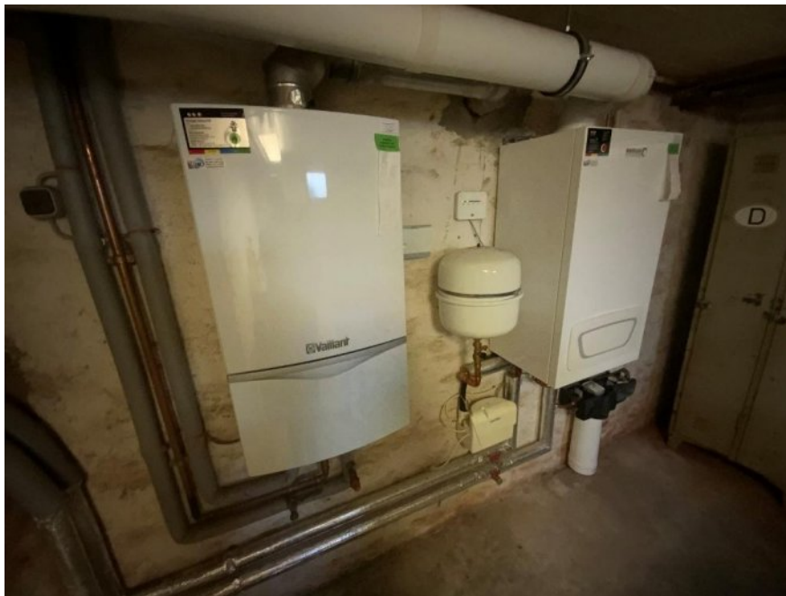
Bild 17: Gasthermen Kellergeschoss
