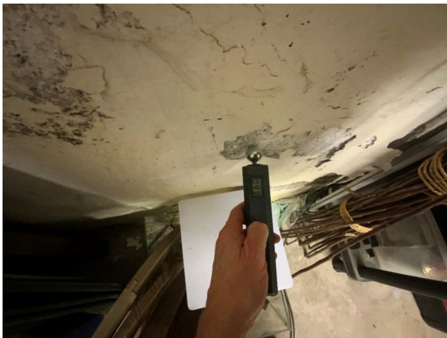
Bild 18: Feuchtigkeitserscheinungen Kellerwand
