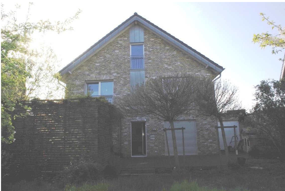
Bild 2: Gartenansicht des Einfamilienhauses aus West
