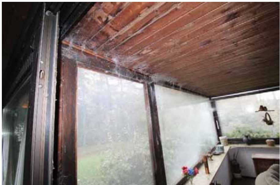
Sicht unter die Decke des Wintergartens / EG
