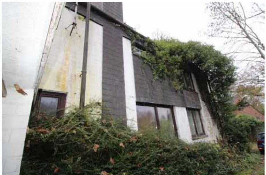
Sicht auf die Nord- Ostansicht des Wohnhauses
