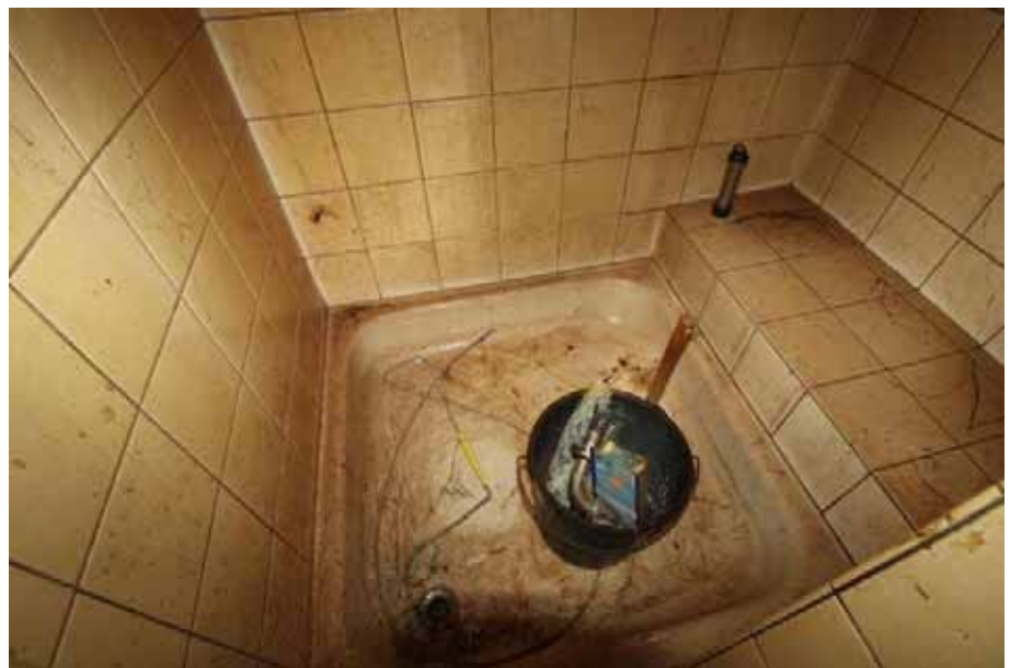
Sicht in die Dusche / EG
