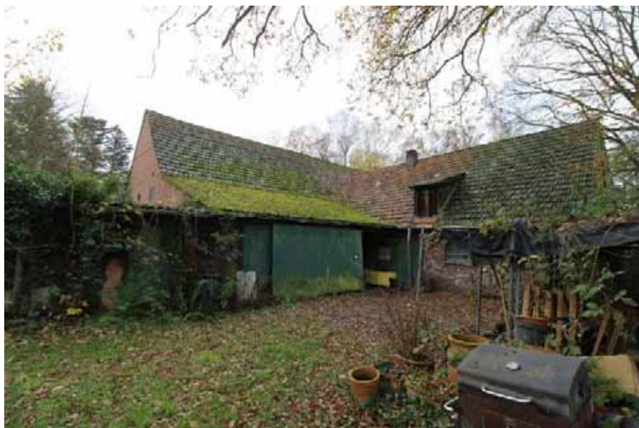
Sicht auf die Scheune (Nordansicht)
