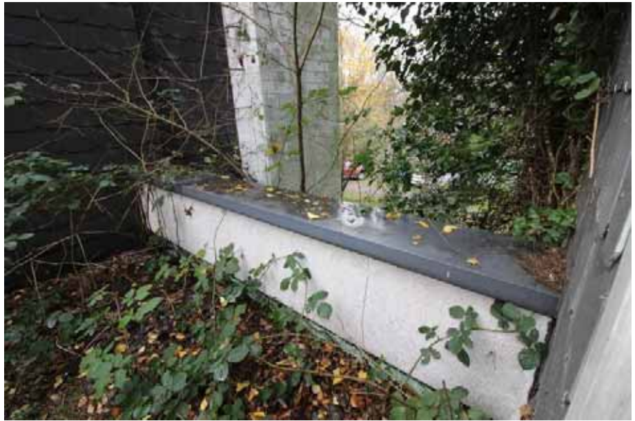
Sicht auf die Brüstung des Flachdachs der Diele im EG / OG
