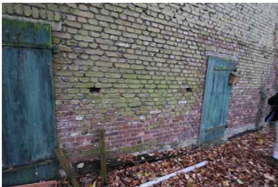
Sicht auf die Scheune (Nordansicht)
