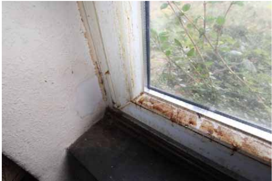
Sicht auf die Fenster im Raum / EG
