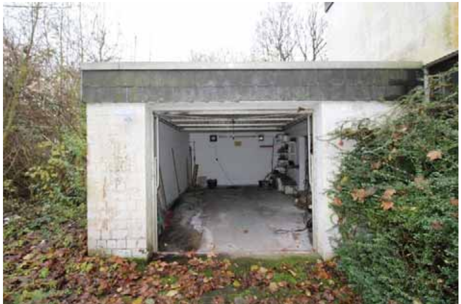
Sicht auf die Pkw- Garage an der Ostsei- te des Wohnhauses
