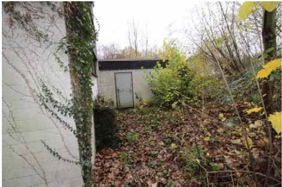
Sicht auf die Zugangstür der Pkw-Garage an der Westseite
