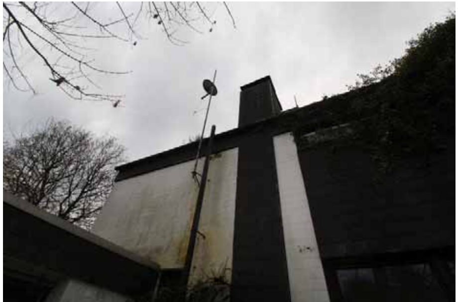
Sicht auf die Nord- Ostansicht des Wohnhauses
