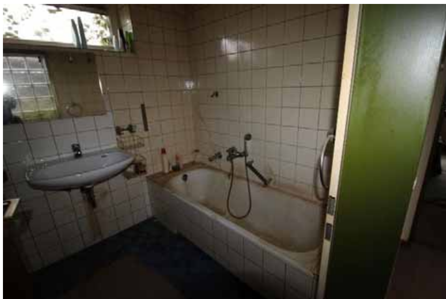
Sicht in das Bad / OG
