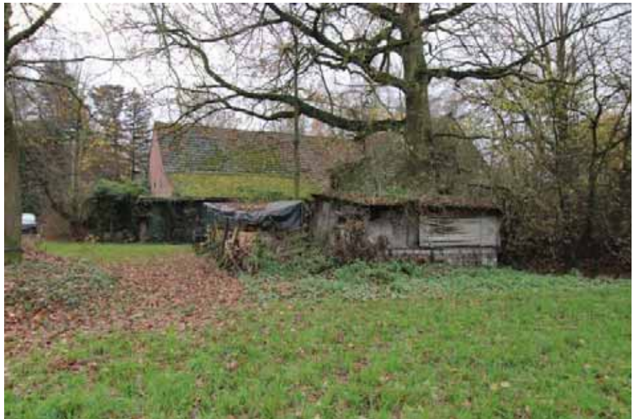
Sicht auf die Scheune (Nordansicht)
