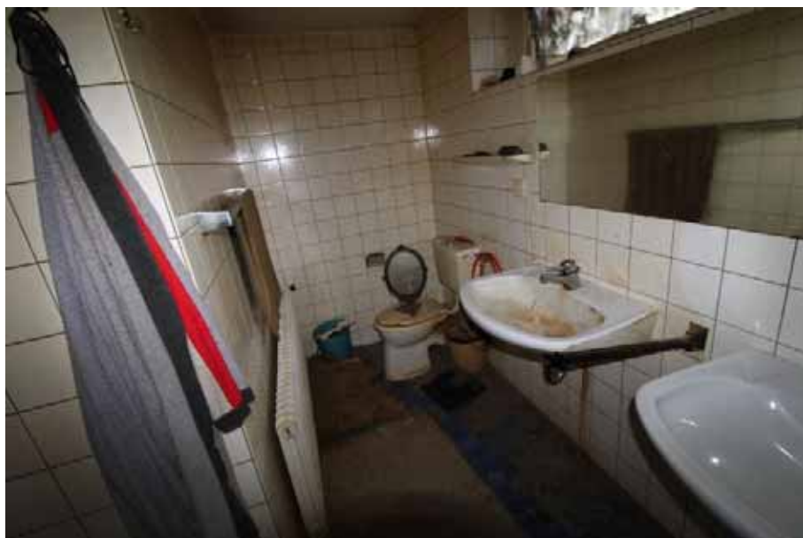
Sicht in das Bad / OG
