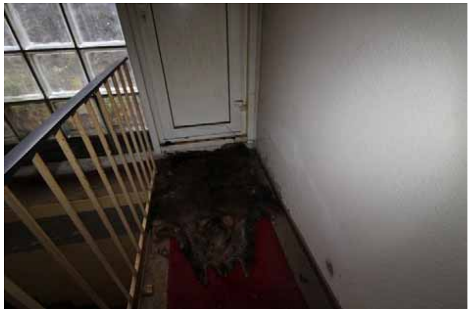
Sicht auf die Tür zum Flachdach der Diele im EG / OG
