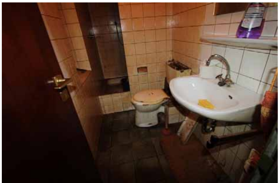
Sicht in das Duschbad / EG
