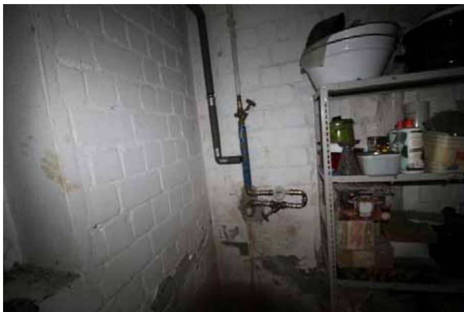
Sicht auf einen Haus- anschluss / KG
