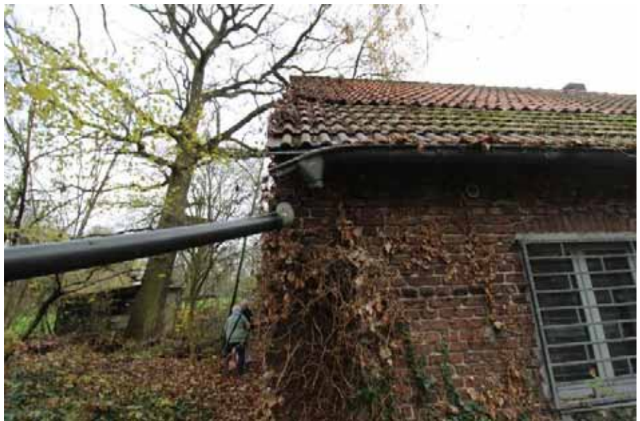
Sicht auf die Dach- entwässerung der Scheune
