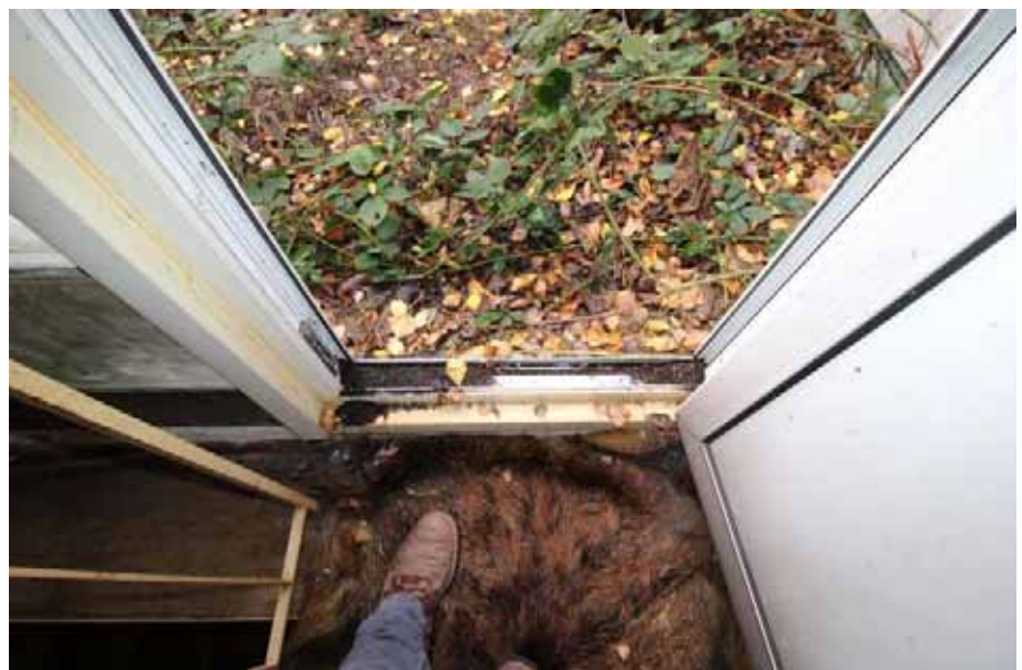
Sicht auf den Zugang zum Flachdach der Diele im EG / OG
