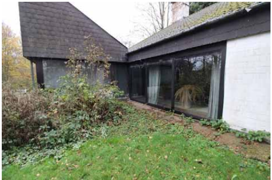
Sicht auf die Westan- sicht mit Wintergarten des Wohnhauses
