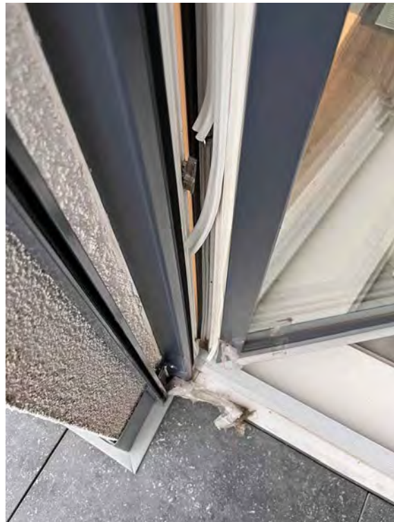
mangelhafte Fensterdichtungen
