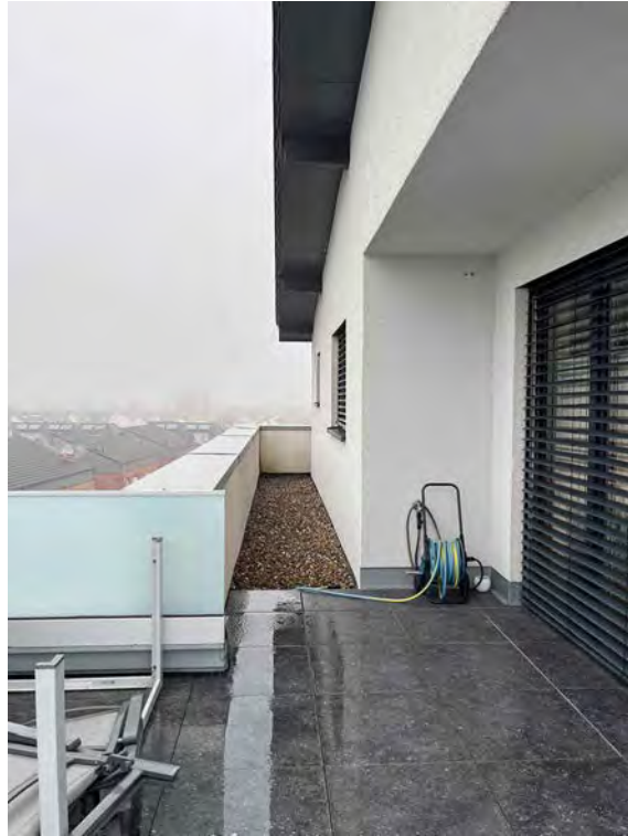
Dachterrasse in Richtung Nordosten
