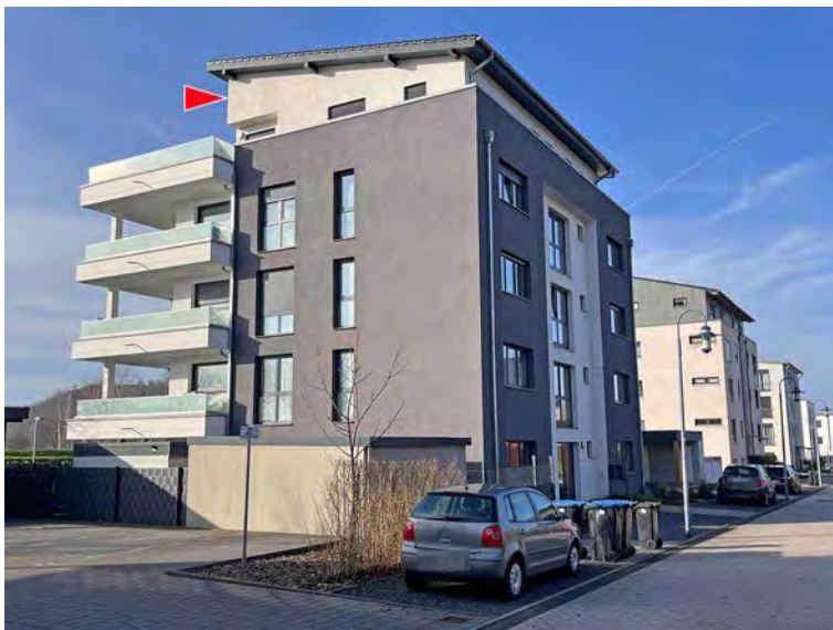
Ansicht von Nordosten mit Hausanschlussraum
