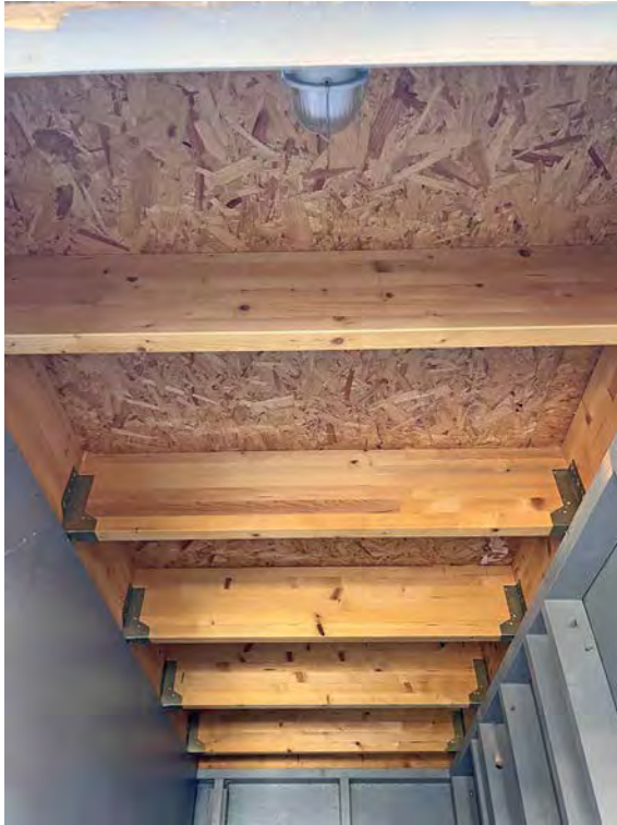
Decke Abstellraum (exemplarisch)
