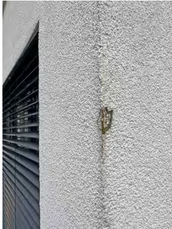
Putzbeschädigung
