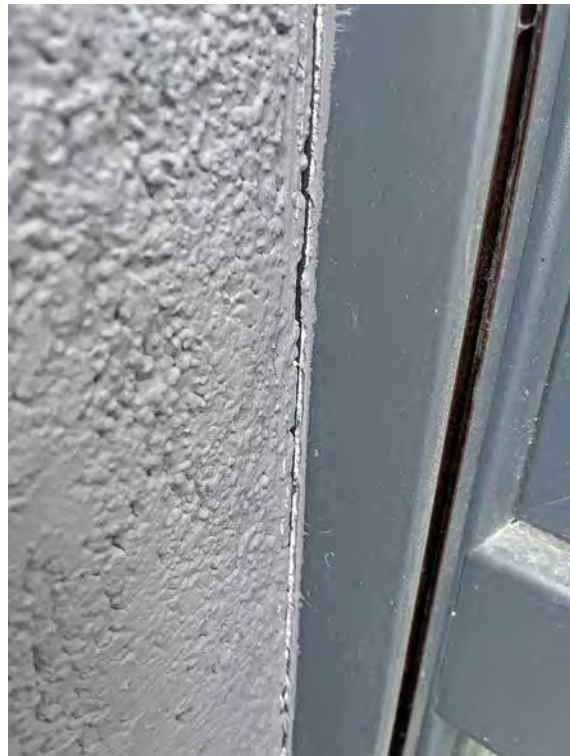
Flankenabriss des Putzes an den Fenstern
