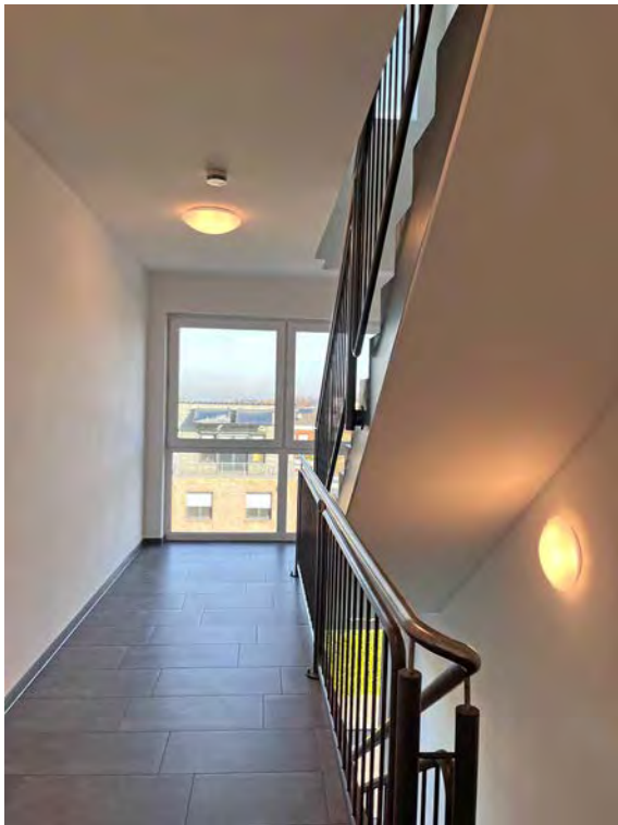
Treppenhaus in Richtung Straße (exemplarisch)
