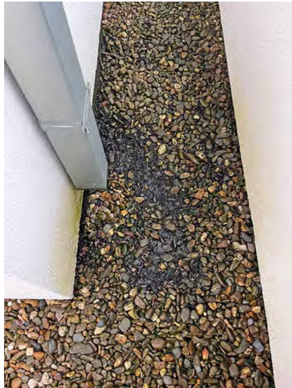
freie Entwässerung des Pultdachs auf die Dachterrasse
