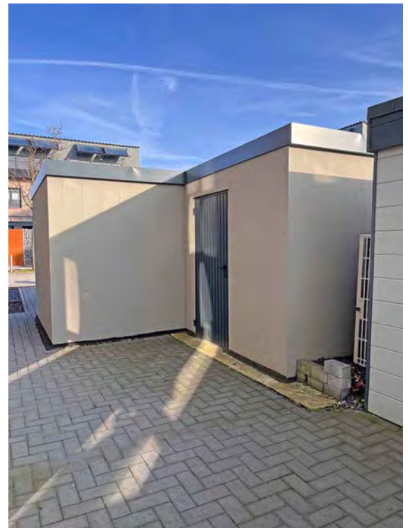
Hausanschlussraum und Fahrradschuppen
