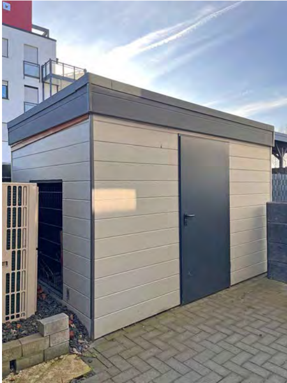
hinterer Fahrradschuppen von außen
