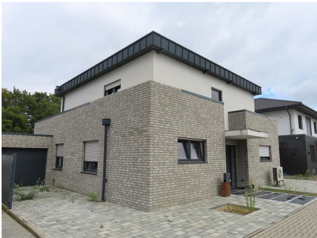
Abb. 1 + 2: Straßen- und Seitenansicht des Wohnhauses
