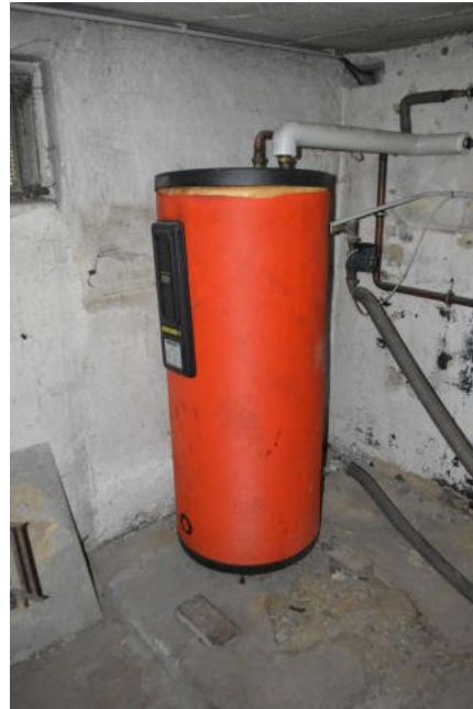
Bild 6: Warmwasserspeicher
