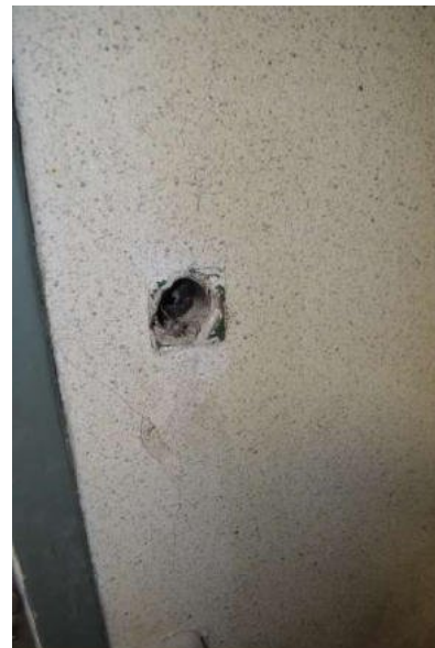
Bild 12: Bsp. Elektro im Treppenhaus
