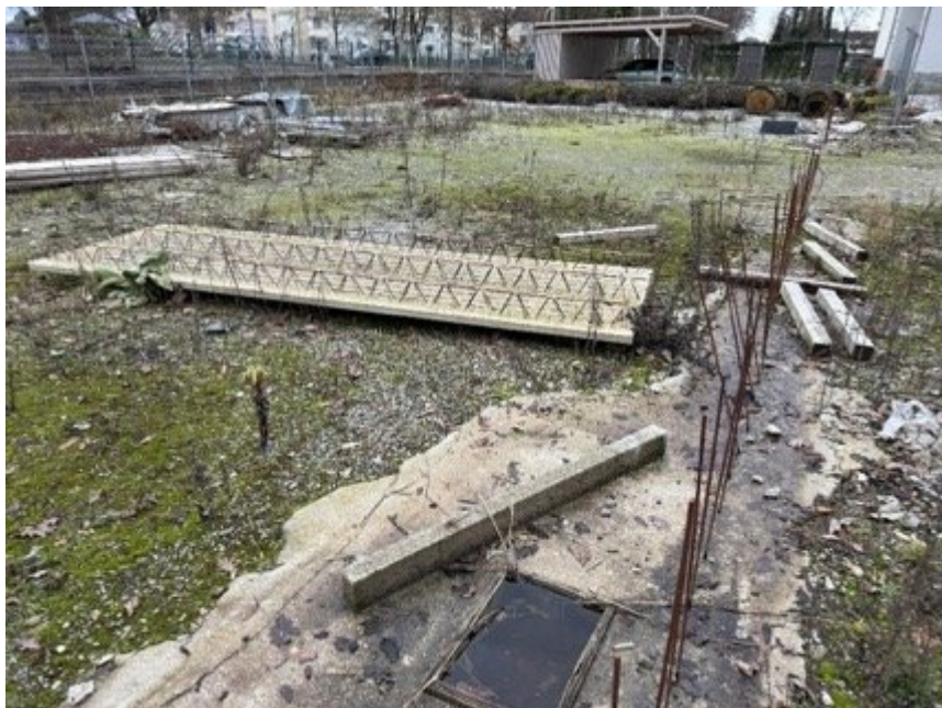
Bild 20: Fundament der geplanten Halle / lose Betonfertigteile ohne feste Verbindung mit dem Grundstück
