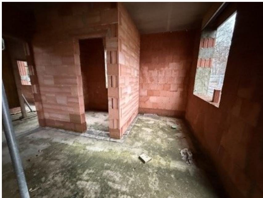
Bild 18: Rohbau Büro (im westlichen Grundstücksbereich)
