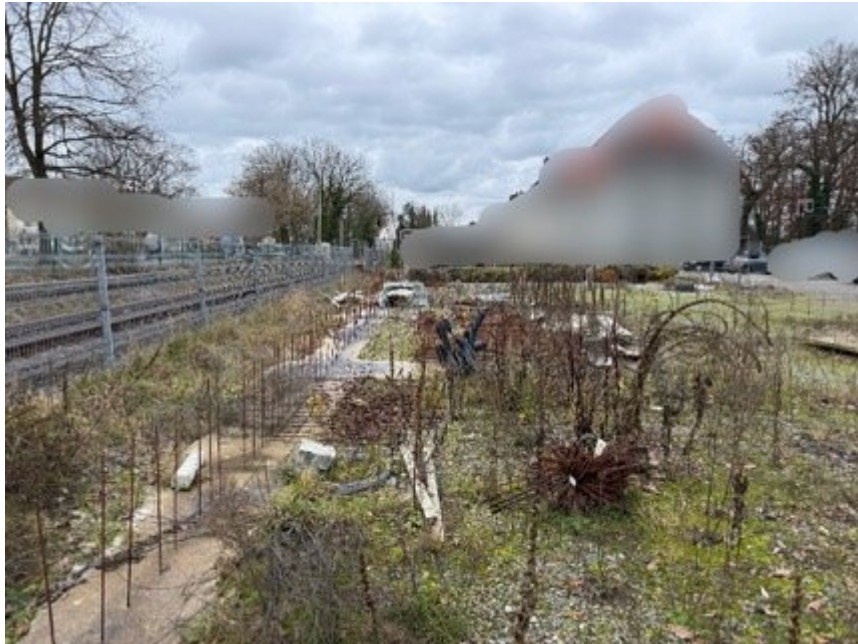
Bild 21: Fundament der geplanten Halle
