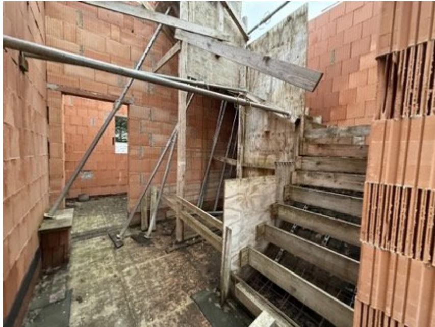
Bild 9: Rohbau Bürogebäude (im südwestlichen Grundstücksbereich zur Beckumer Straße)
