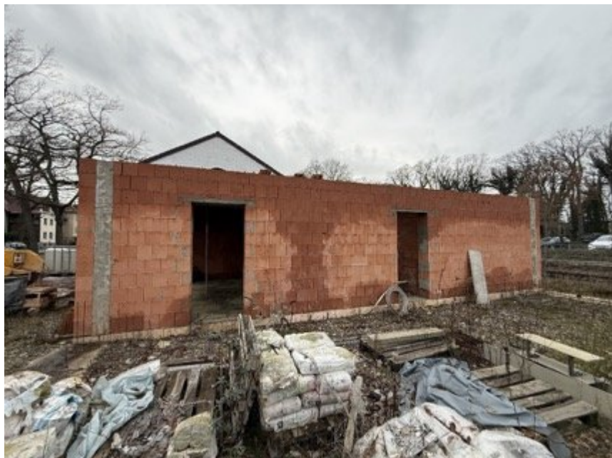
Bild 14: Rohbau Büro (im westlichen Grundstücksbereich)
