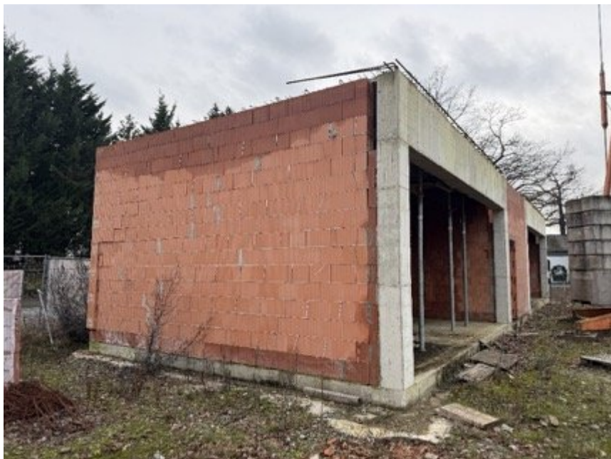
Bild 4: Rohbau Bürogebäude (im südwestlichen Grundstücksbereich zur Beckumer Straße)
