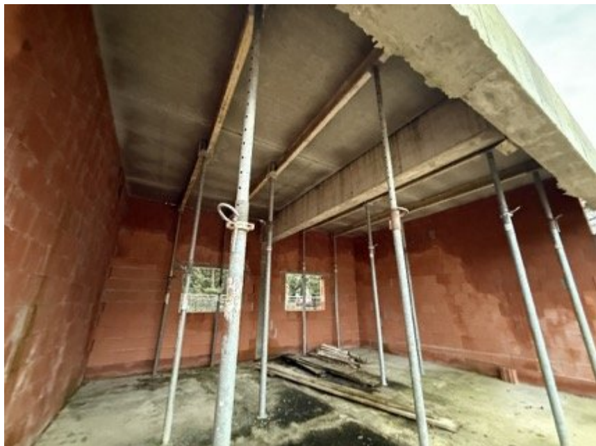
Bild 12: Rohbau Bürogebäude (im südwestlichen Grundstücksbereich zur Beckumer Straße)
