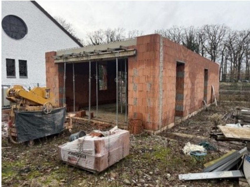
Bild 13: Rohbau Büro (im westlichen Grundstücksbereich)
