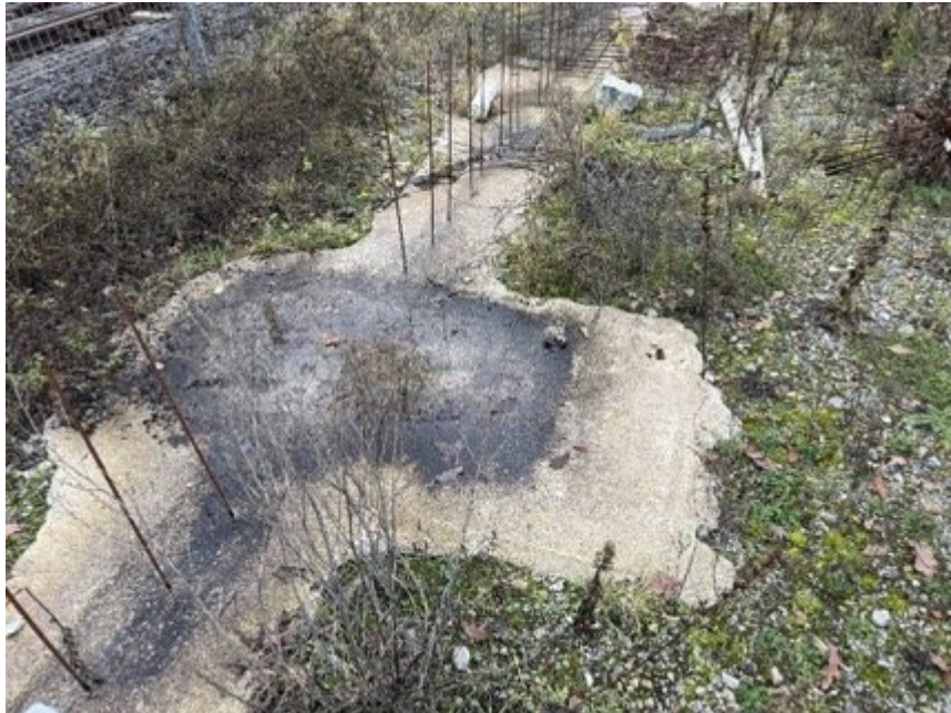
Bild 19: Fundament der geplanten Halle
