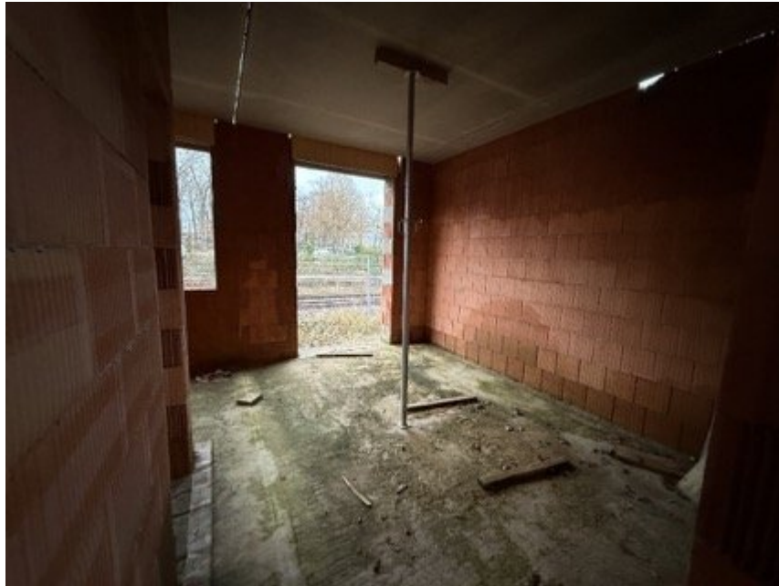
Bild 17: Rohbau Büro (im westlichen Grundstücksbereich)
