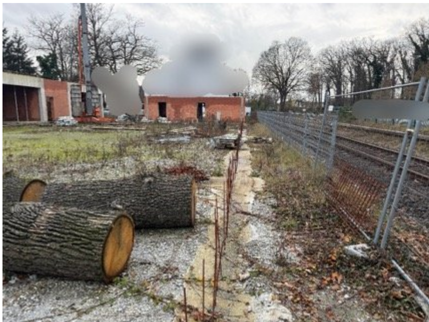
Bild 22: Fundament der geplanten Halle / lose Baumstammteile
