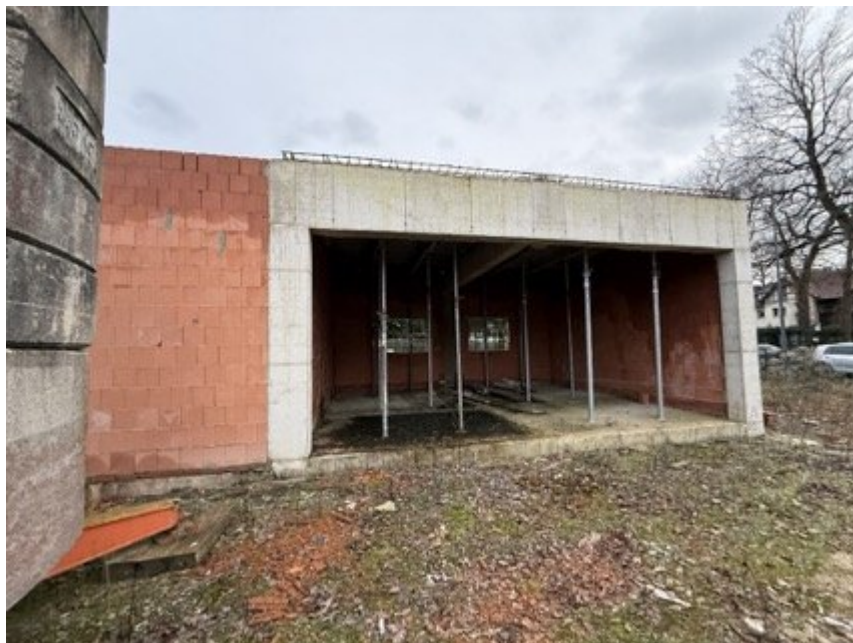
Bild 6: Rohbau Bürogebäude (im südwestlichen Grundstücksbereich zur Beckumer Straße)
