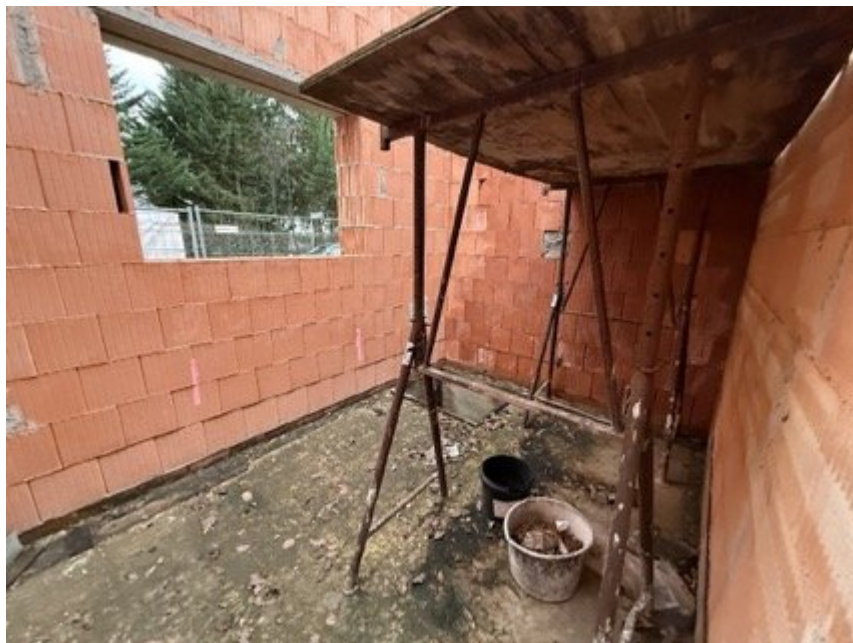
Bild 10: Rohbau Bürogebäude (im südwestlichen Grundstücksbereich zur Beckumer Straße)
