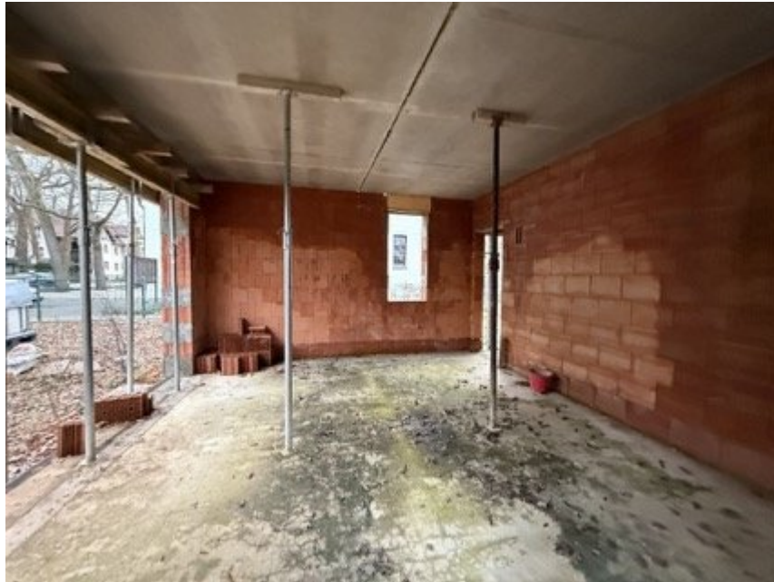
Bild 15: Rohbau Büro (im westlichen Grundstücksbereich)
