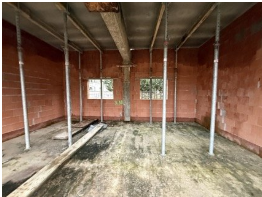
Bild 8: Rohbau Bürogebäude (im südwestlichen Grundstücksbereich zur Beckumer Straße)
