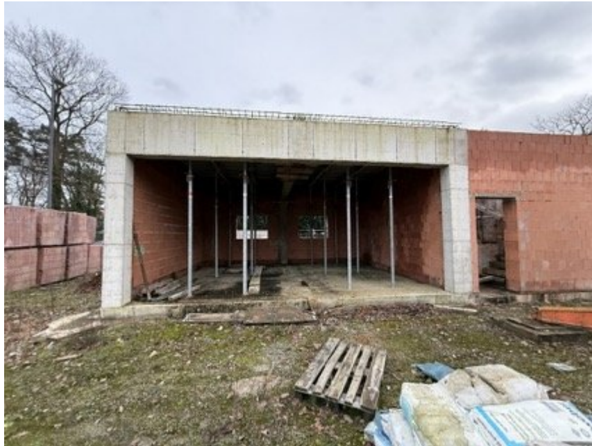
Bild 5: Rohbau Bürogebäude (im südwestlichen Grundstücksbereich zur Beckumer Straße)
