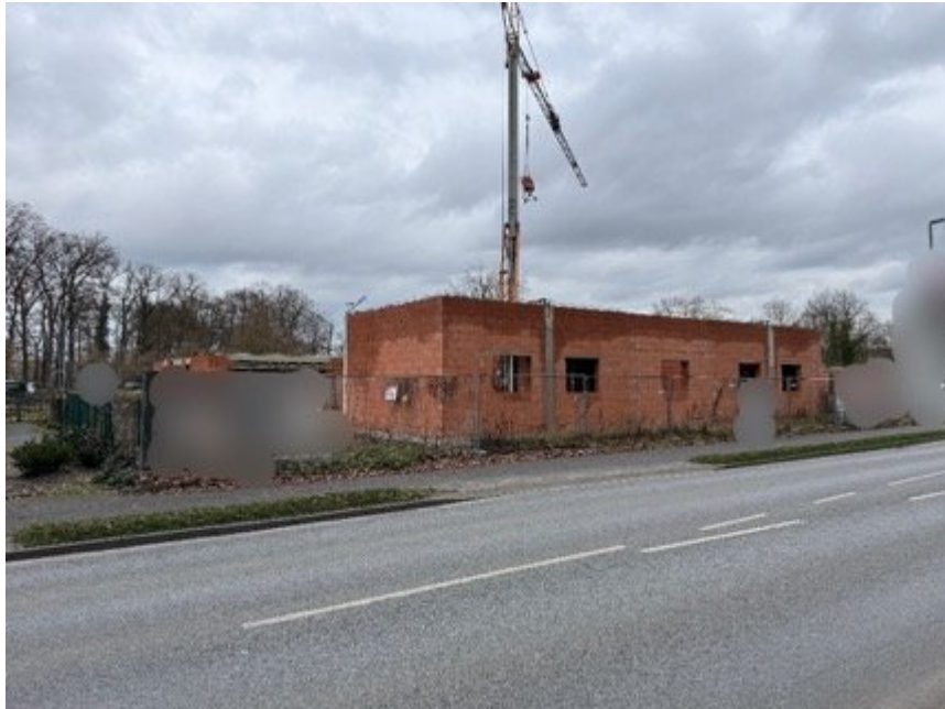
Bild 3: Rohbau Bürogebäude (im südwestlichen Grundstücksbereich zur Beckumer Straße)
