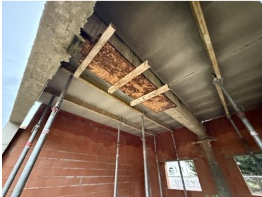
Bild 7: Rohbau Bürogebäude (im südwestlichen Grundstücksbereich zur Beckumer Straße)
