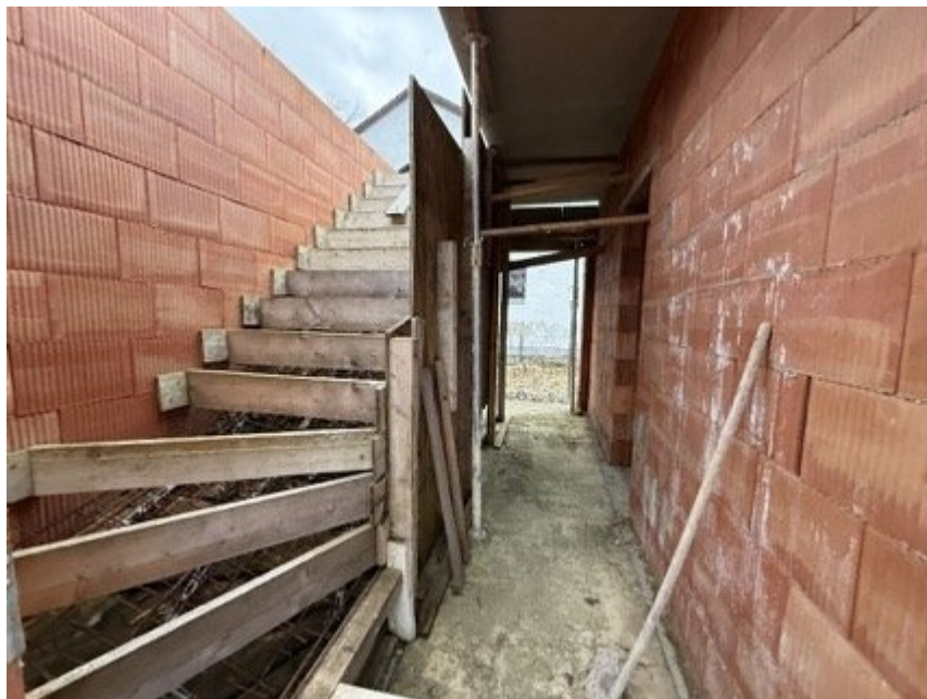
Bild 16: Rohbau Büro (im westlichen Grundstücksbereich)
