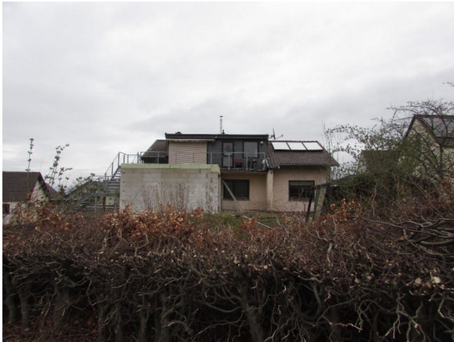
Foto 9: Wohnhaus mit nicht fertiggestelltem Anbau, Ansicht von der "Merzbacher Straße"
