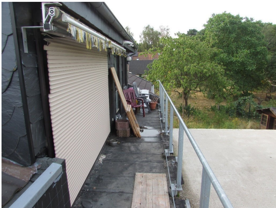
Foto 6: Wohnhaus Eingangsbereich DG
