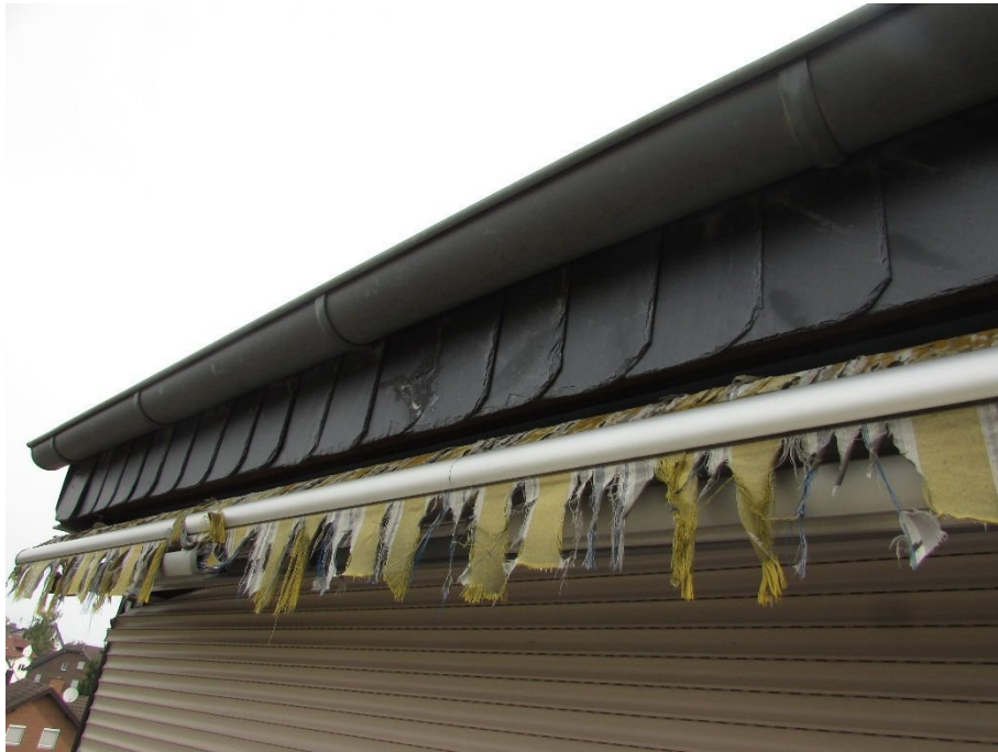
Foto 13: beschädigte Markise
