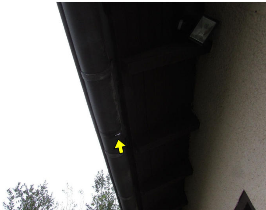
Foto 4: Wohnhaus: beschädigte Dachrinne
