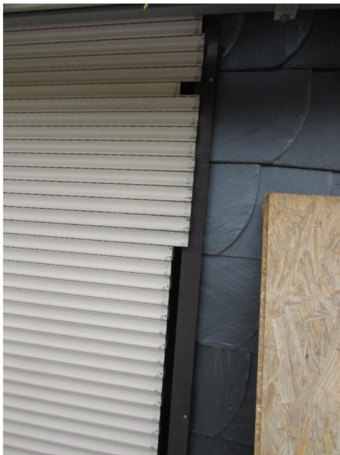
Foto 12: beschädigte Kunststoffrolläden
