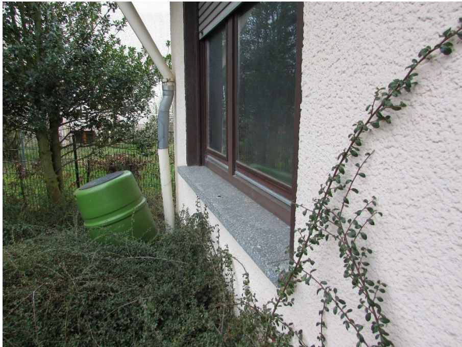
Foto 7: Wohnhaus, isolierverglaste Holzfenster
