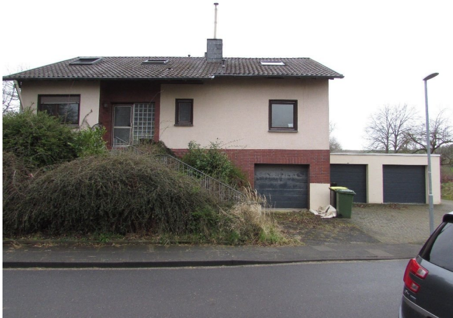
Foto 1: Wohnhaus, Ansicht von der "Weidenstraße"
