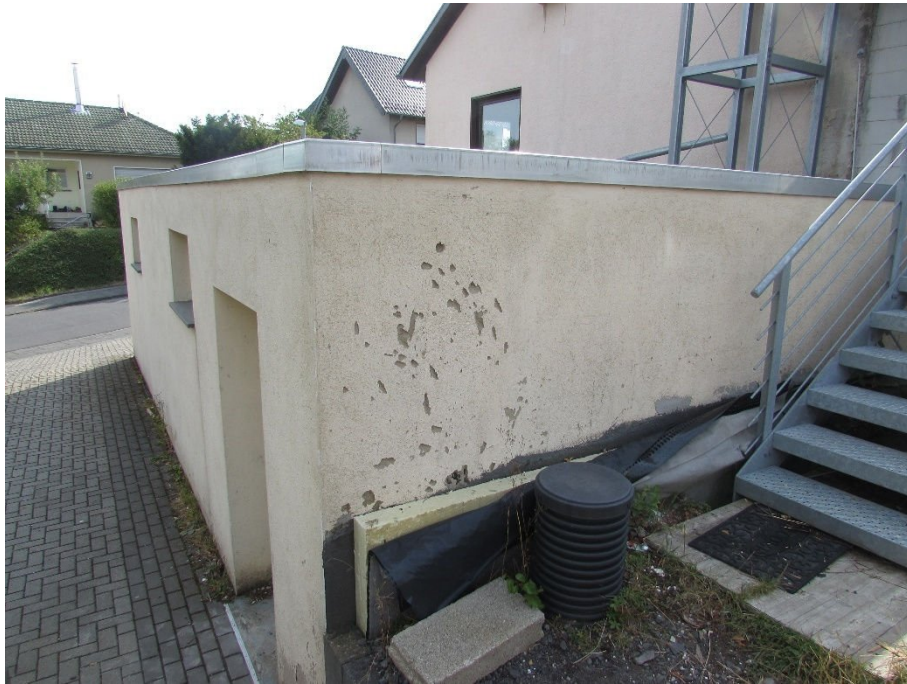
Foto 15: PKW-Doppelgarage Putzschäden
