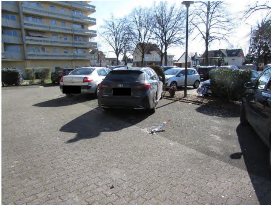
Foto 5: abweichend vom Aufteilungsplan angelegter Parkplatz (Bereich der Stellplätze gemäß Lageplan)
