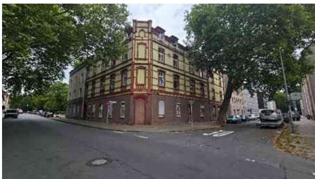
Blick von der Achternbergstraße auf das Wertermittlungsobjekt mit den Mehrfamilienhäusern.
