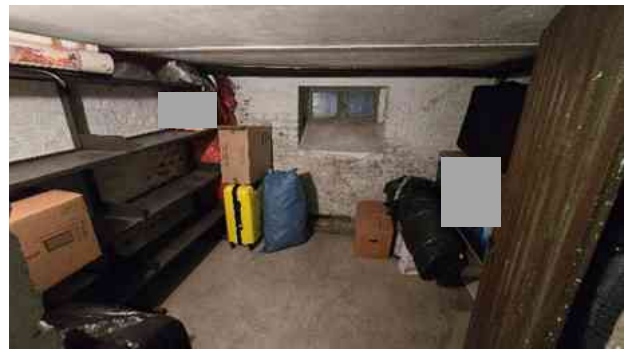
A68; Lagerkellerraum zur Mietwohnung.
