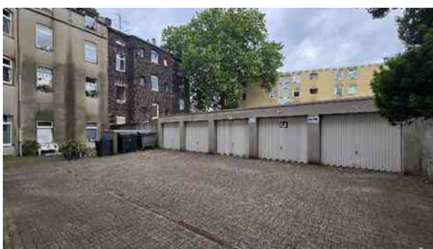
Hofseitiger Blick auf die Garagenanlage.
