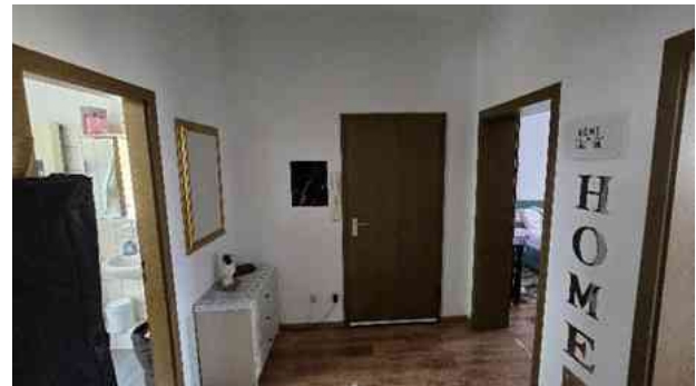
WE 68.3; Diele mit Blick auf Türanlagen und Elektrounterverteilung.
