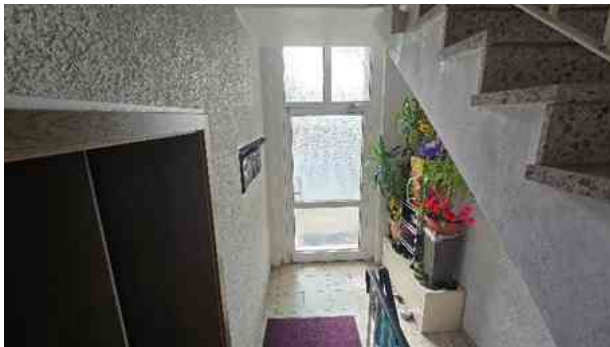
A68, EG; Hausflur mit Blick auf die Hauseingangstür.
