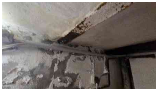
S48, KG; Rost unter den Eisenträgern der Decke und Feuchtigkeitsschäden an den Wandflächen.
