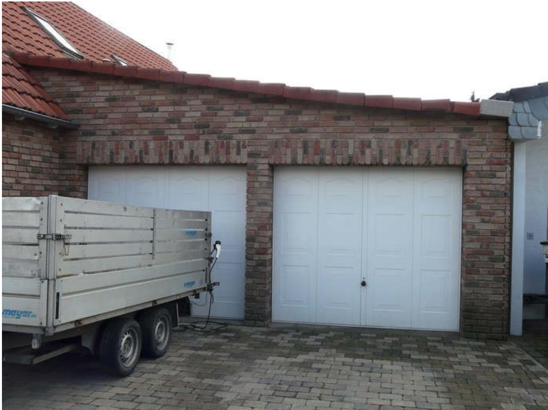
Ansicht von Nordwesten (Doppelgarage)
