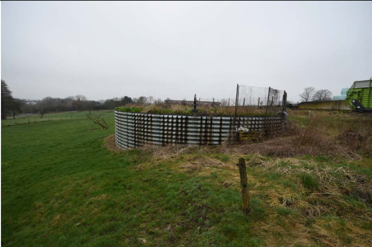
Bild 35 Metallrundsilo zur Güllelagerung
