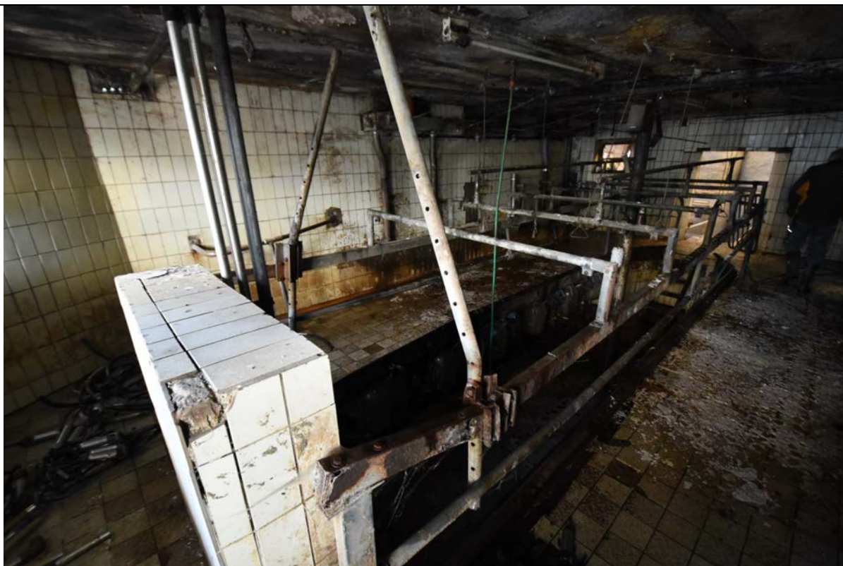
Bild 41 Blick in den ungenutzten ehemaligen Melkstand
