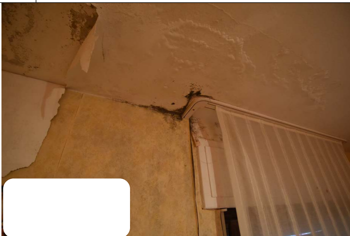
Bild 10 Wohnraum im Dachgeschoss mit erheblichem Feuchtigkeits- und Schimmelbefall
