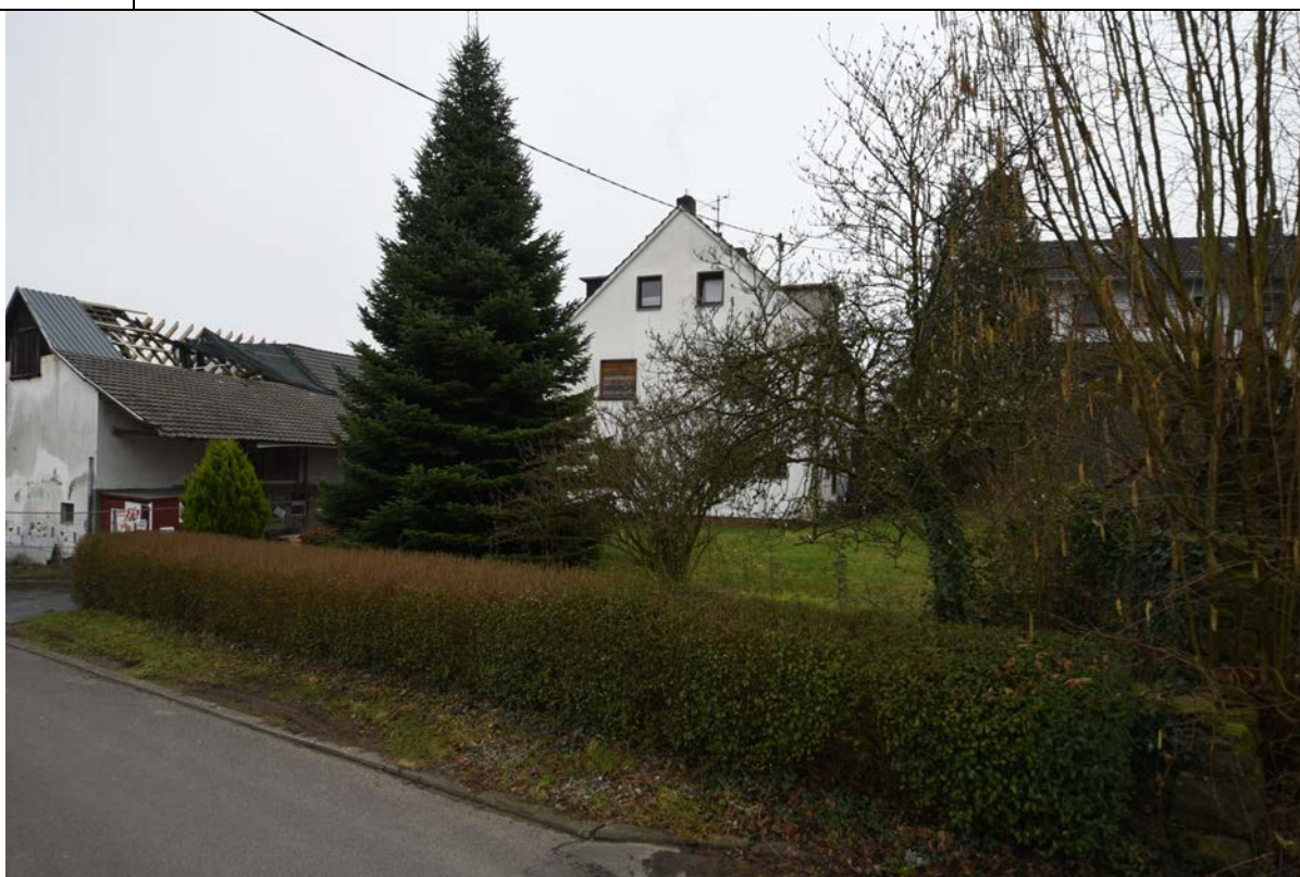
Bild 4 Giebelansicht des Wohnhauses mit stark geschädigtem Dachstuhl des Wirtschaftsgebäudes (links im Bild)
