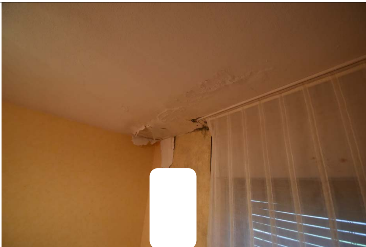
Bild 9 Wohnraum im Obergeschoss mit Feuchtigkeit Decke und Wand sowie daraus resultierendem starken Schimmelbefall
