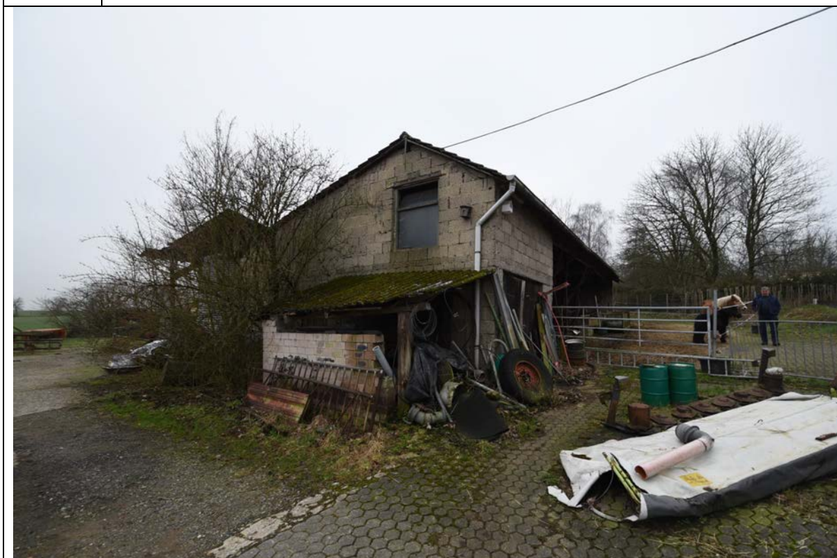
Bild 18 Blick auf den seitlichen Giebel des Offenstalls
