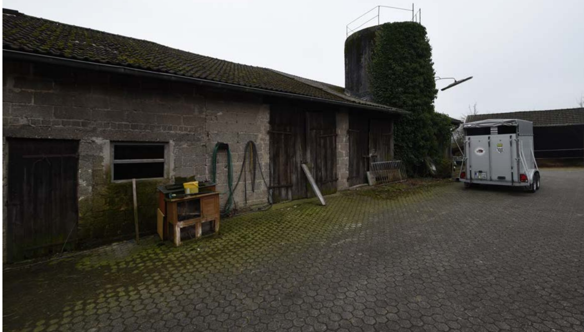
Bild 15 Blick auf die Wirtschaftsgebäude (ehemaliger Schweinestall) mit geschädigten Toren und Türen und starkem Moosbefall der befestigten Fläche sowie Grünbewuchs des nicht mehr genutzten Betonsilos für Grassilage
