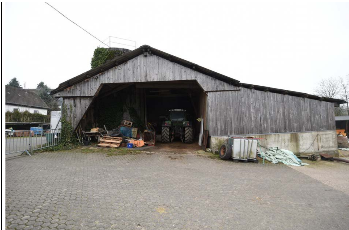
Bild 17 Blick auf den südwestlichen Giebel der Wirtschaftsgebäude
