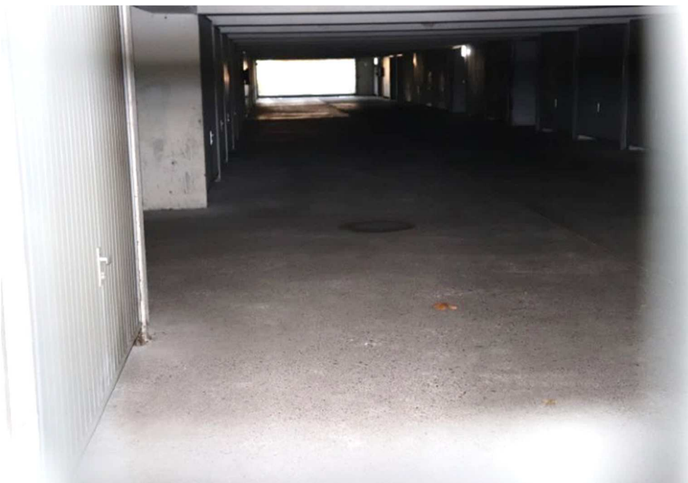
Bild 12 Innenraum Tiefgarage mit Blick zum Tiefgarageneinfahrtstor (von der rückseitig gelegenen Notausgangstür aus aufgenommen)
