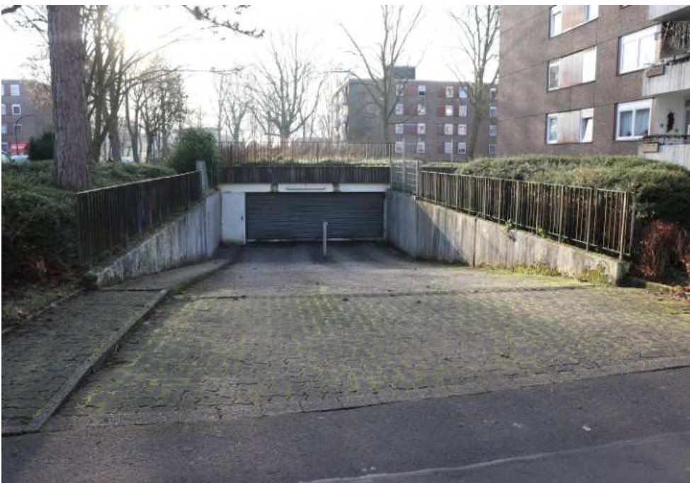
Bild 10 Zufahrt zur Tiefgarage
