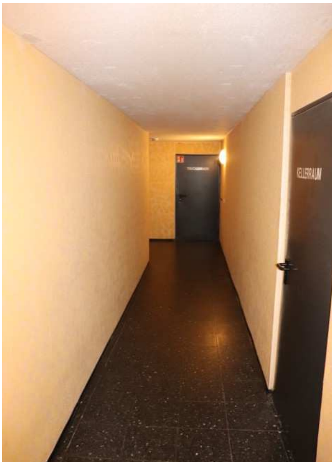
Bild 16 Waterloostraße 6, Unter-/Kellergeschoss -Verteilerflur mit Zugang zu den Kellerräumen-
