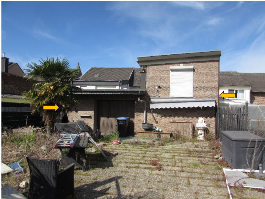
Foto 11: Wohnhaus, Rückansicht, integrierte PKW-Garage im Erdgeschoss
