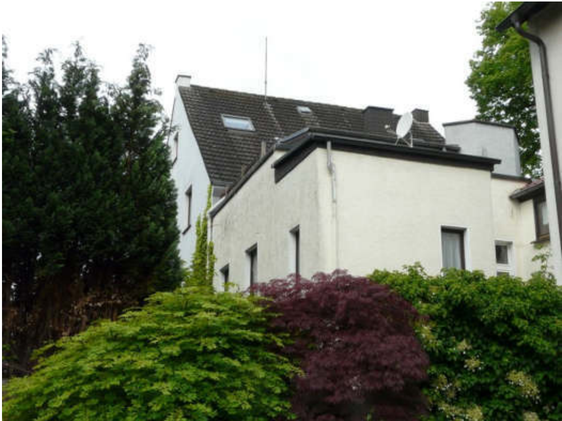
Teilansicht von Südosten
