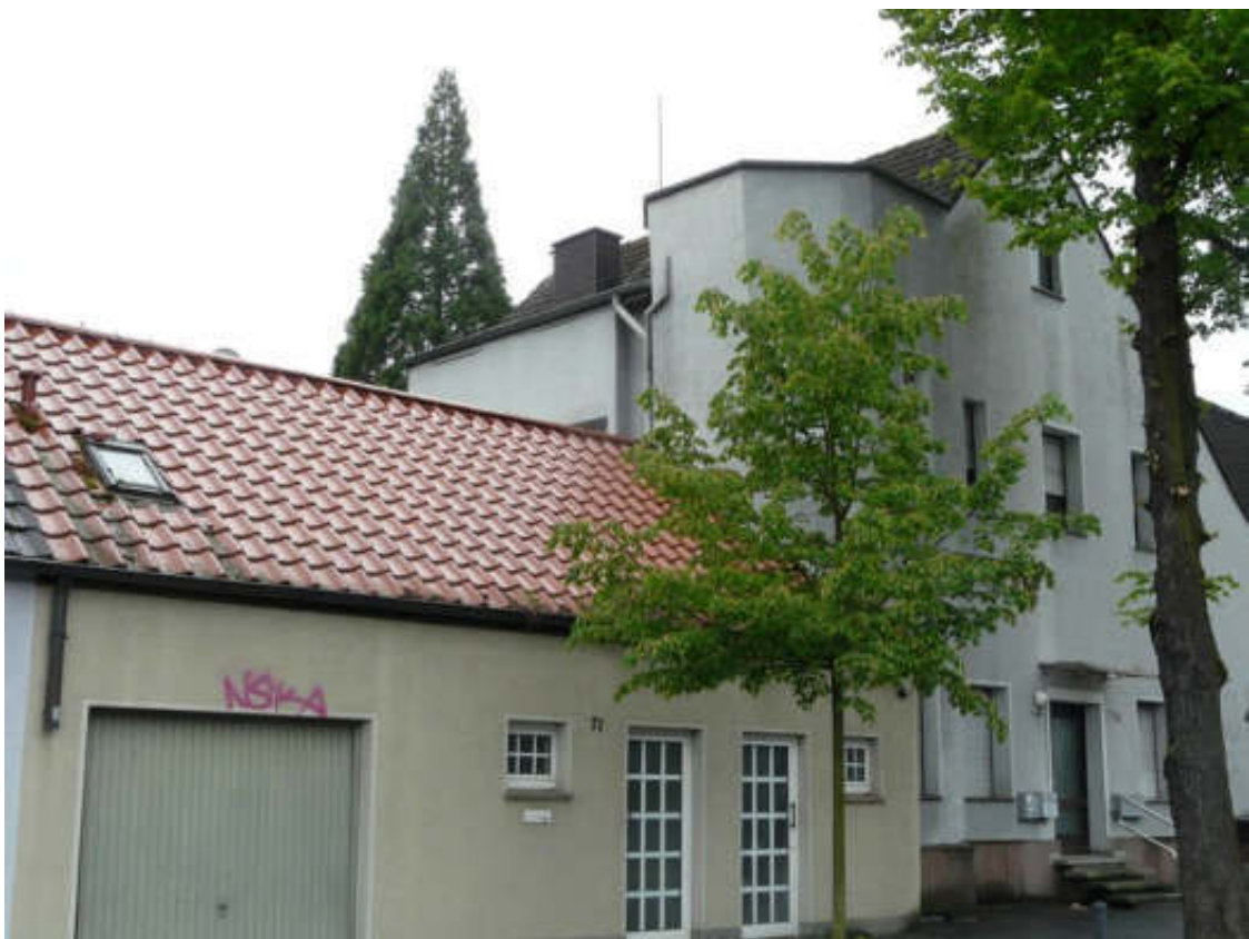
Ansicht von Nordosten
