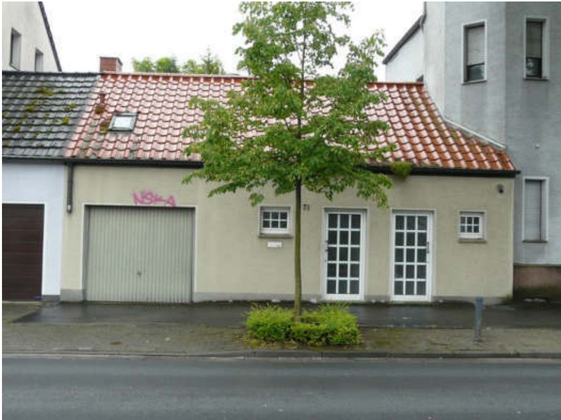
Teilansicht von Norden (Anbau HsNr. 71)
