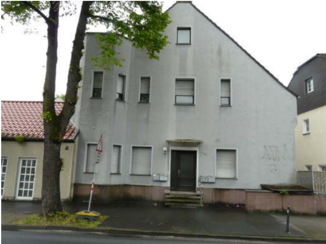
Teilansicht von Norden (Hauptgebäude HsNr. 71 a)
