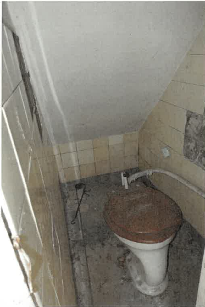
Gäste-WC unter Treppe
