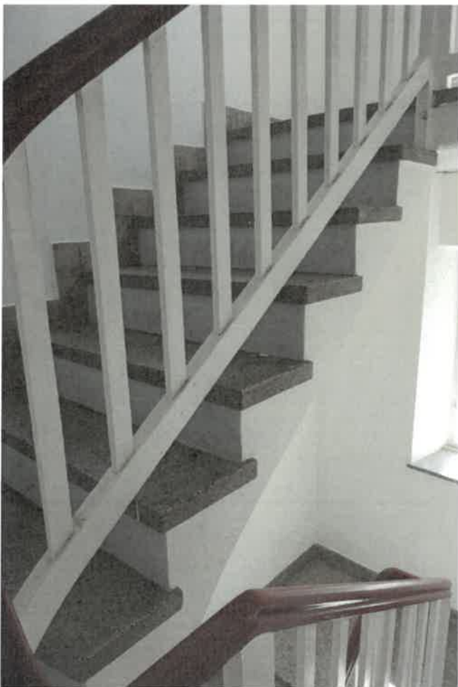
Treppe 1.OG / 2. OG
